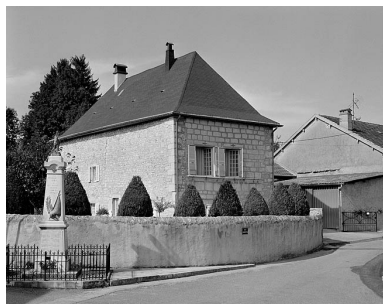
Demeure de notable dite le Château.
