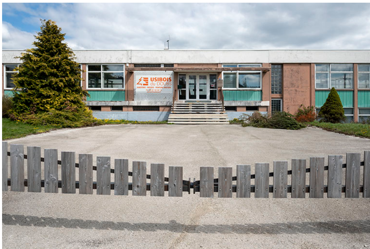
Façade antérieure : entrée.
