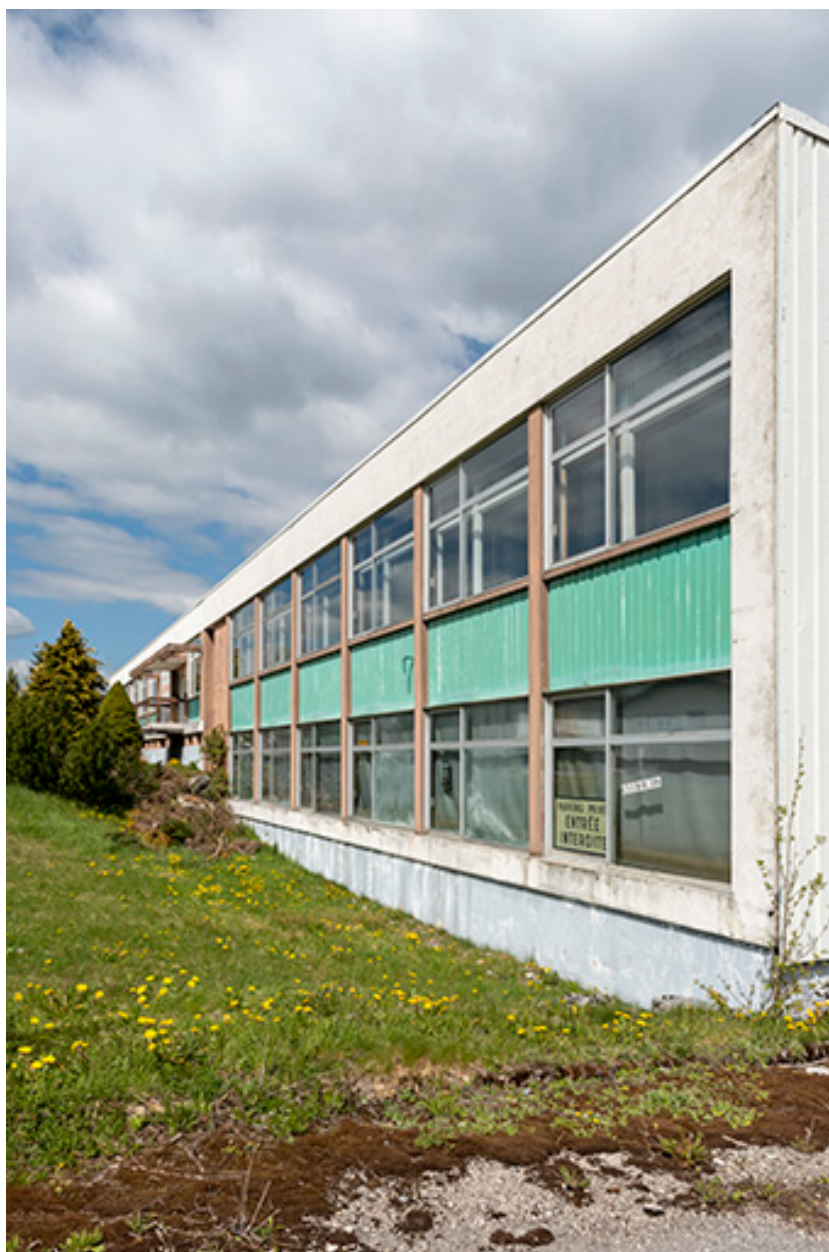
Façade antérieure, vue en enfilade.
