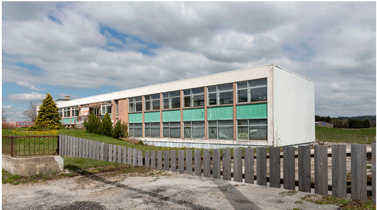
Façades antérieure et latérale droite.
