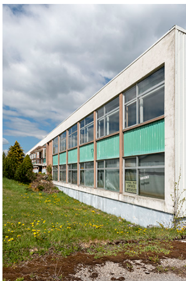
Façade antérieure, vue en enfilade. Phot. Sonia Dourlot IVR43_20192500415NUC4A
