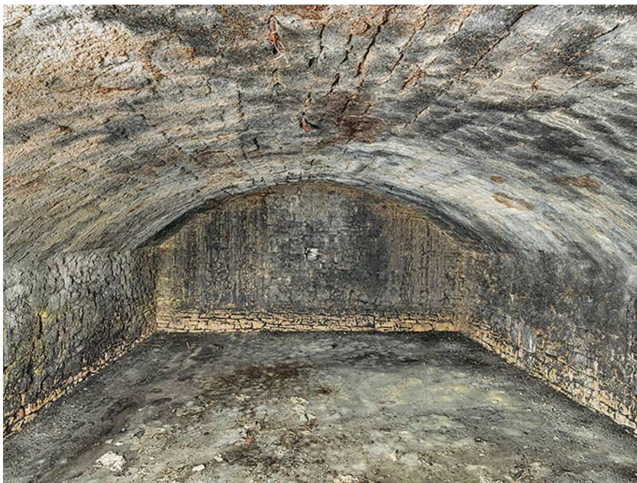
Autre casemate du niveau inférieur.
