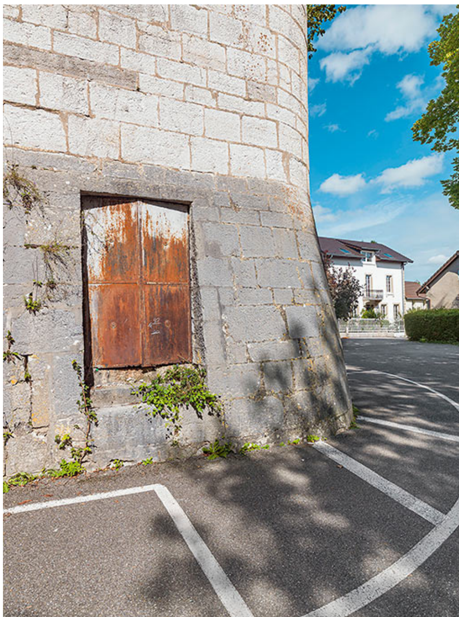
Poterne du demi-bastion.
