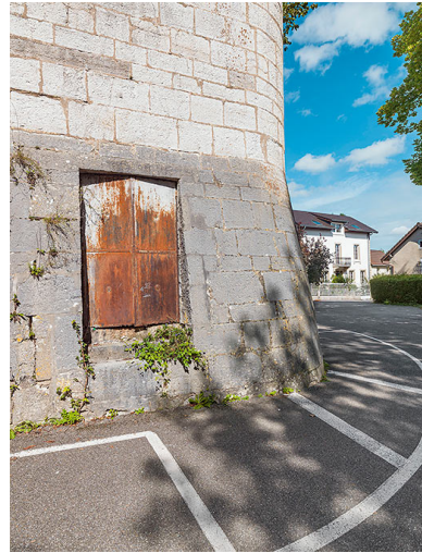
Poterne du demi-bastion. Phot. Thierry Kuntz IVR43_20252500058NUC4A
