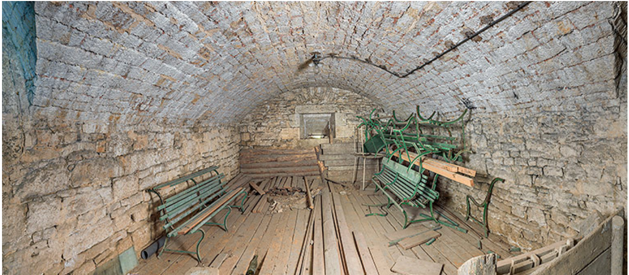
Vue générale d'une casemate.
