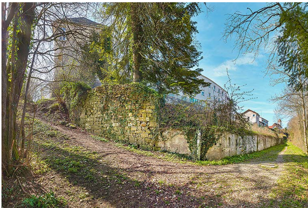
Mur d'enceinte dans le prolongement du front.
