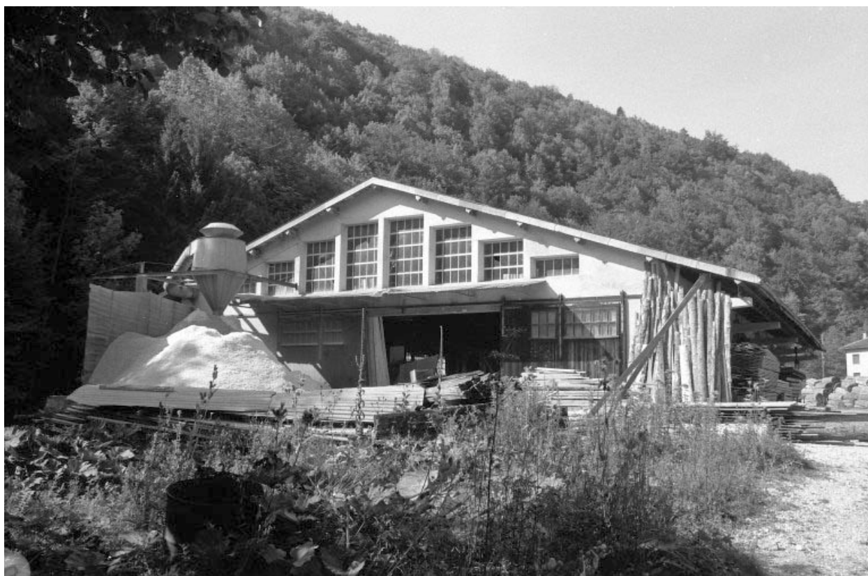
Façade postérieure de la scierie.
