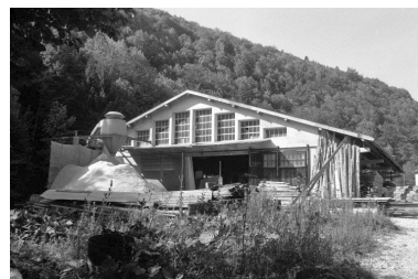
Façade postérieure de la scierie. Phot. Laurent Poupard IVR43_19903900459Z
