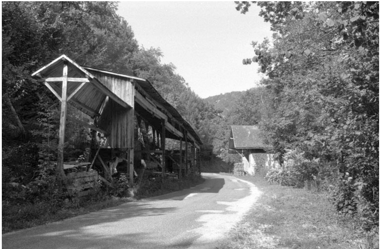
Séchoir à bois et magasin industriel.
