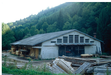
Scierie vue de trois quarts gauche. Phot. Laurent Poupard IVR43_19903900457ZA
