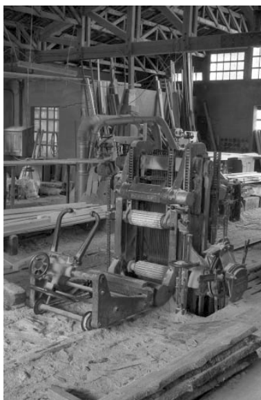
Scie Socolest vue de trois quarts. Phot. Laurent Poupard IVR43_19903900462Z
