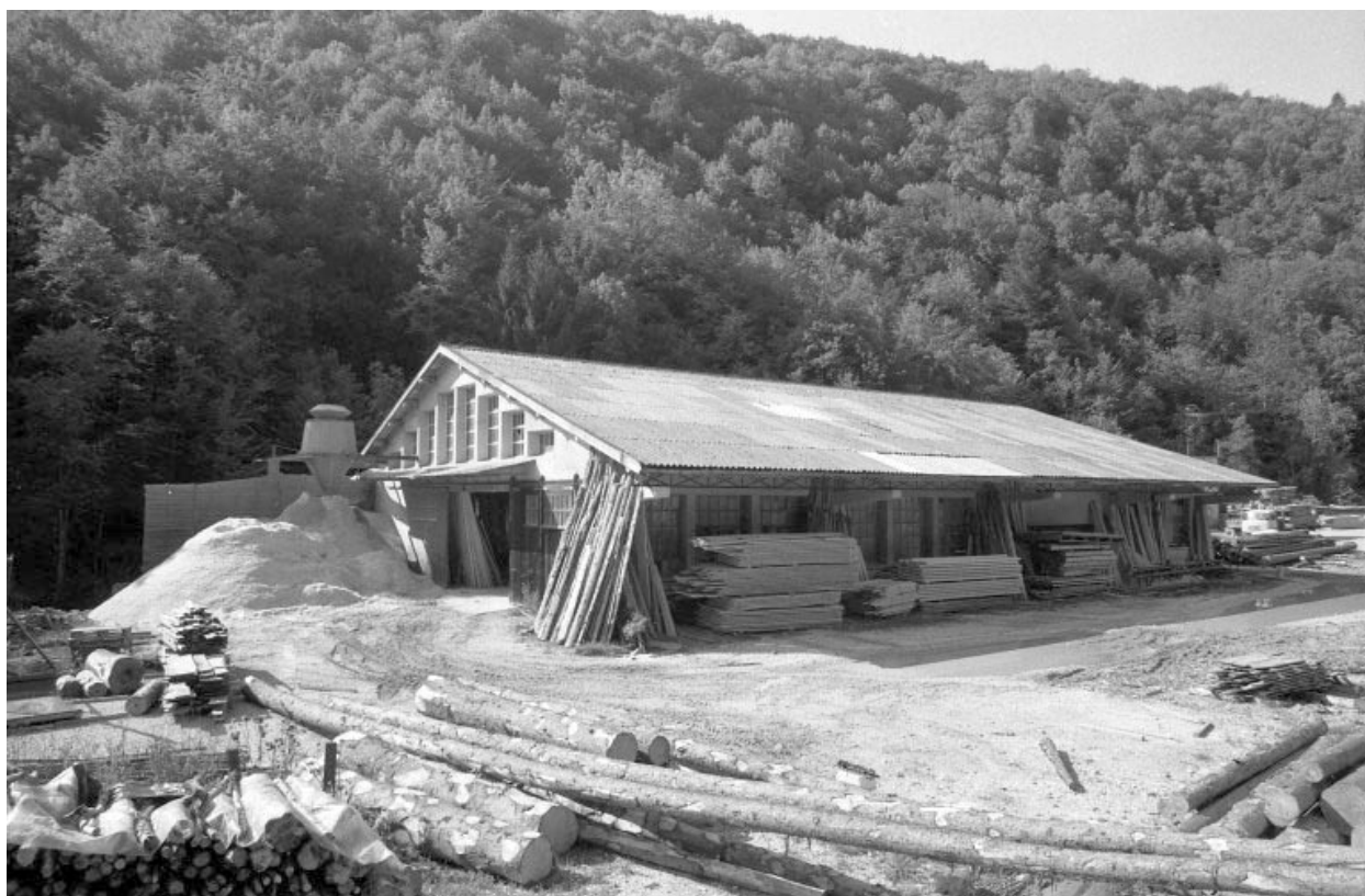
Façade latérale gauche de la scierie.
