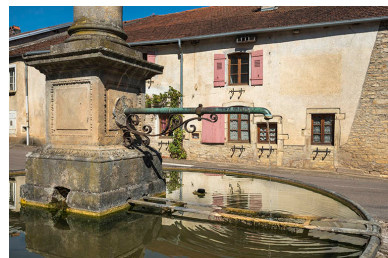
Le bassin et la base de la colonne. Phot. Jérôme Mongreville IVR43_20177001281NUC4A
