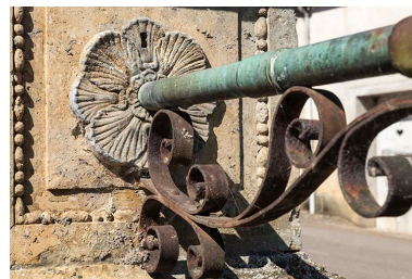
Détail du jet en fonte. Phot. Jérôme Mongreville IVR43_20177001283NUC4A
