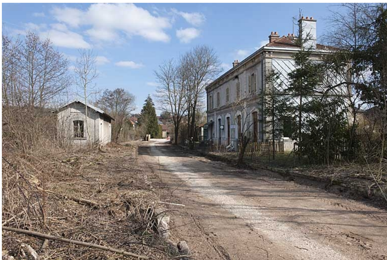
Bâtiment des voyageurs et abri.
