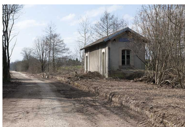
Abri de voyageurs. Phot. Jérôme Mongreville IVR43_20112500343NUC4A
