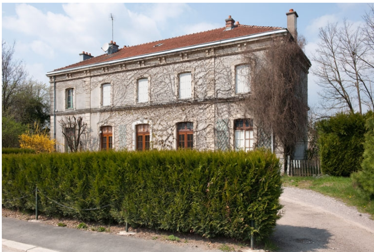
Bâtiment des voyageurs.
