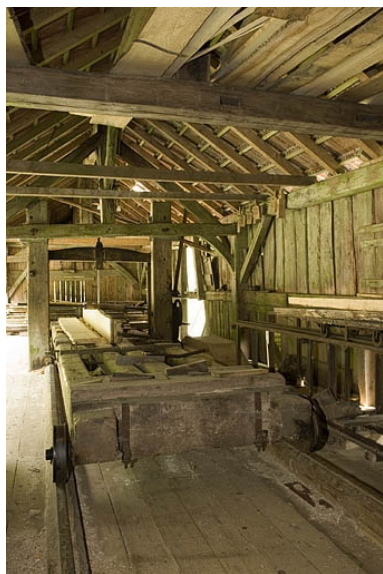
Intérieur de l'atelier. Phot. Jérôme Mongreville IVR43_20067000405NUCA
