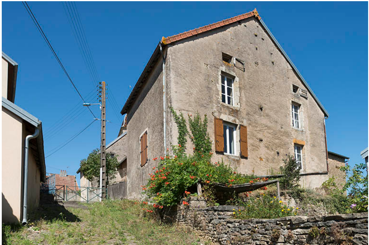
Le mur pignon côté sud.
