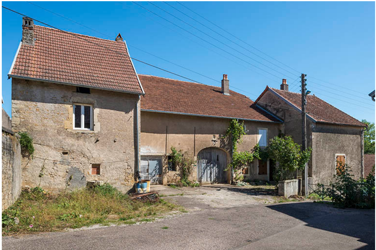
La façade antérieure.
