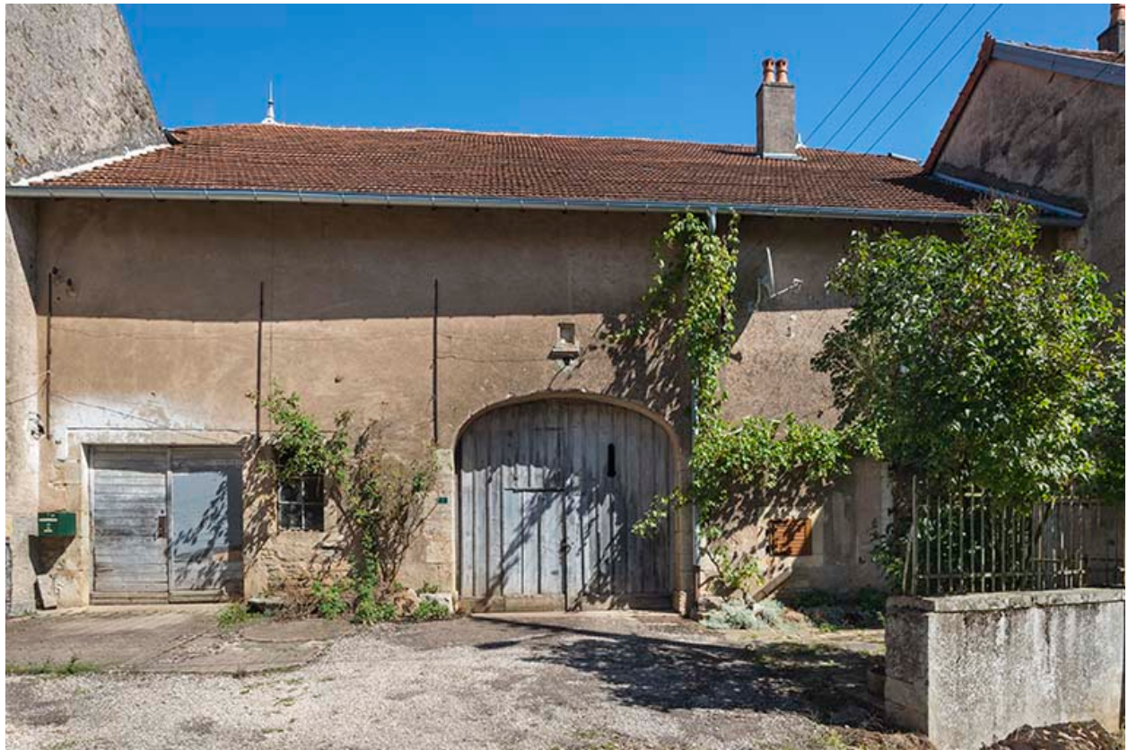
La porte cochère de la grange.
