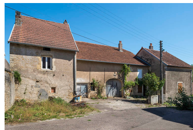
La façade antérieure. Phot. Jérôme Mongreville IVR43_20177001216NUC4A
