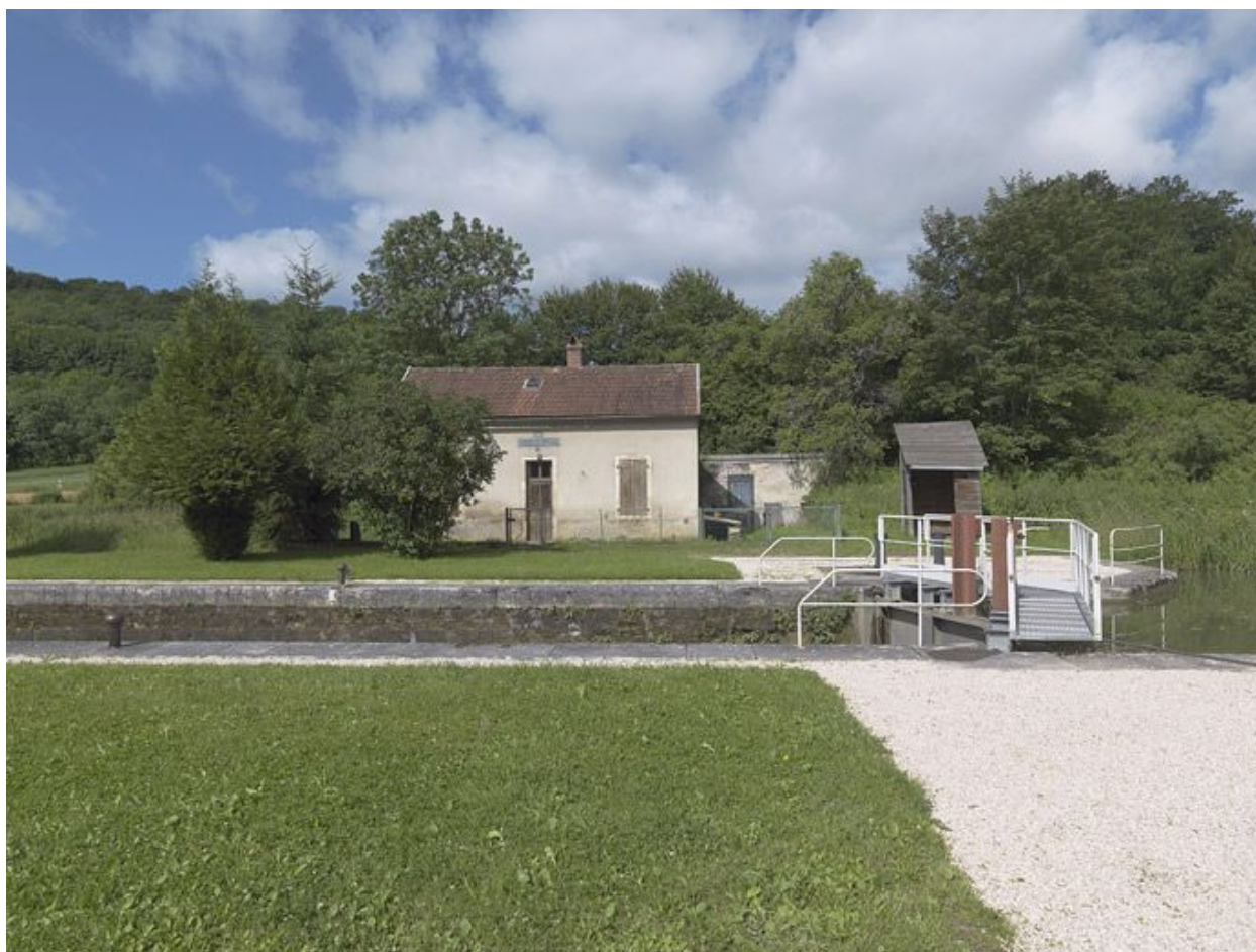
Maison éclusière de face.
