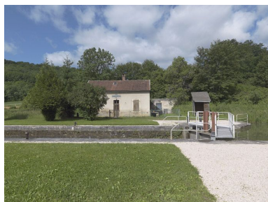
Maison éclusière de face. Phot. Thierry Kuntz IVR26_20122102275NUC4A
