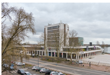
Nièvre, Nevers. Centre culturel (maison de la culture), gymnase et bourse du travail. Phot. Pierre-Marie Barbe-Richaud IVR26_20245800035NUC4A
