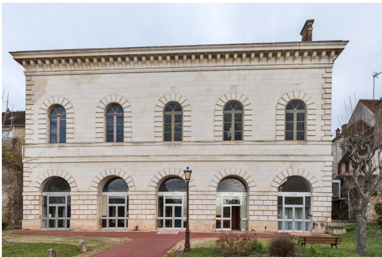
Yonne, Joigny. Halle et théâtre municipal, actuellement salle Claude Debussy : façade postérieure.
