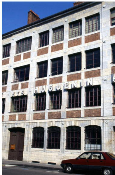
Détail de la façade antérieure en 1996. Phot. Jérôme Mongreville IVR43_19962500147ZA
