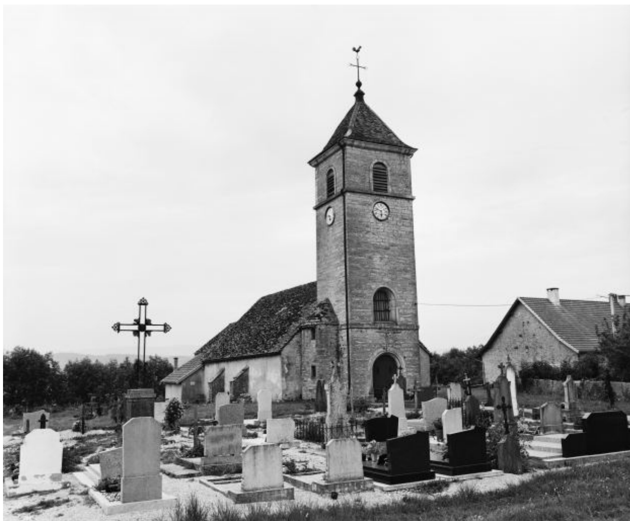
Façades antérieure et latérale gauche.
