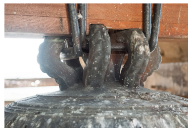
Détail du cerveau : colombettes 2-4-6. Phot. Pierre-Marie Barbe-Richaud IVR26_20177100075NUC2A
