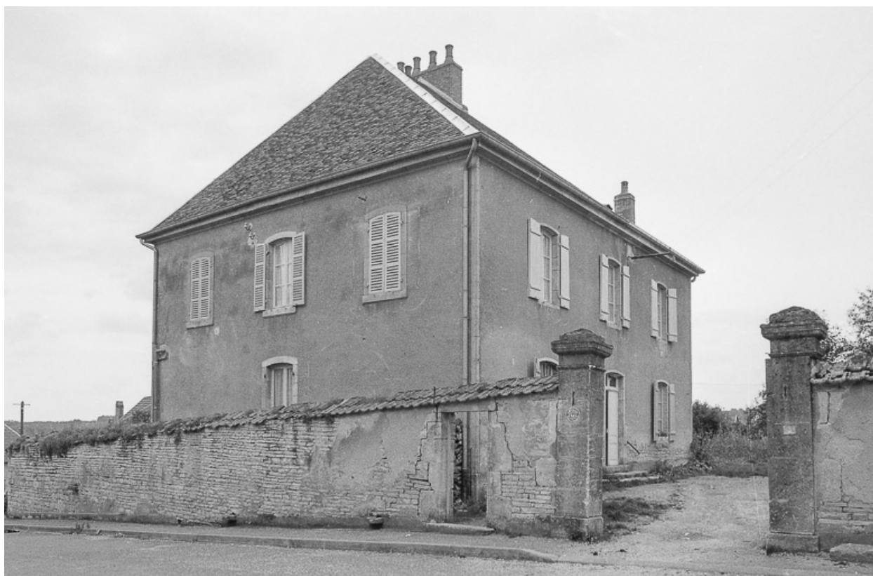
Façade sur cour.
