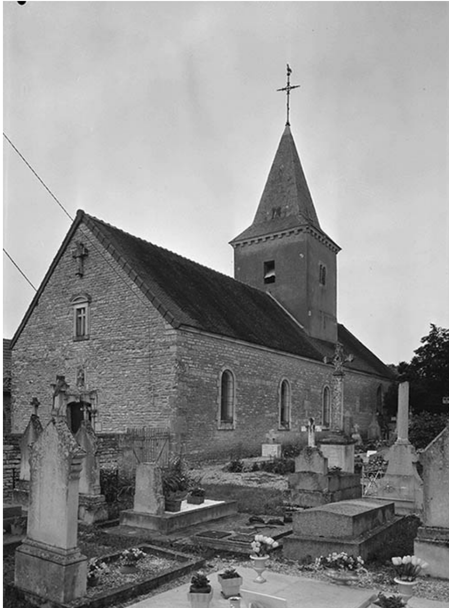
Façade occidentale et bas-côté sud.
