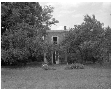
Vue de l'orangerie au fond du parc. Phot. Yves Sancey IVR43_19887000038X
