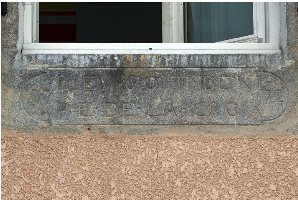
Linteau remployé comme appui de fenêtre.
