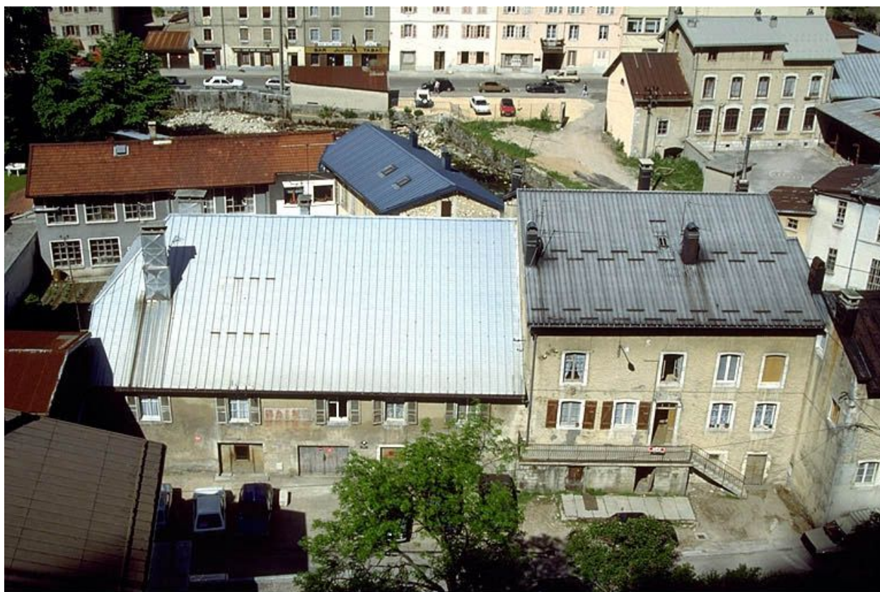
Vue d'ensemble plongeante depuis l'est.
