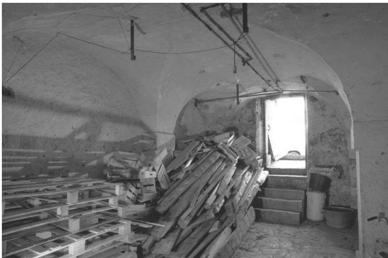
Pièce voûtée, en sous-sol.
