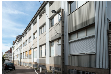
Façade du bâtiment sud. Phot. Jérôme Mongreville IVR43_20172501115NUC4A
