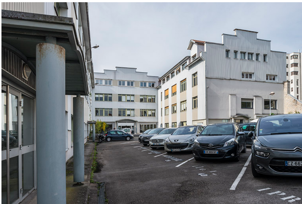
Bâtiment nord depuis la cour.
