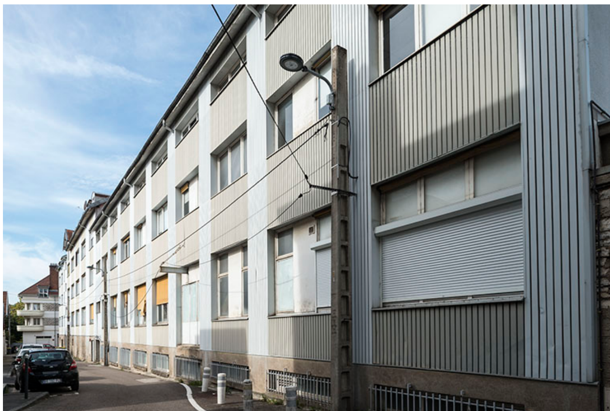
Façade du bâtiment sud.
