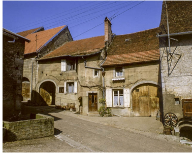
Façade antérieure. Phot. Yves Sancey IVR43_19827000529XA
