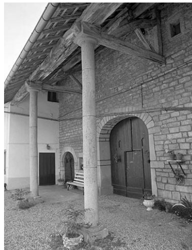
Façade antérieure : détail de l'avant-toit. Phot. Yves Sancey IVR43_19813900156X
