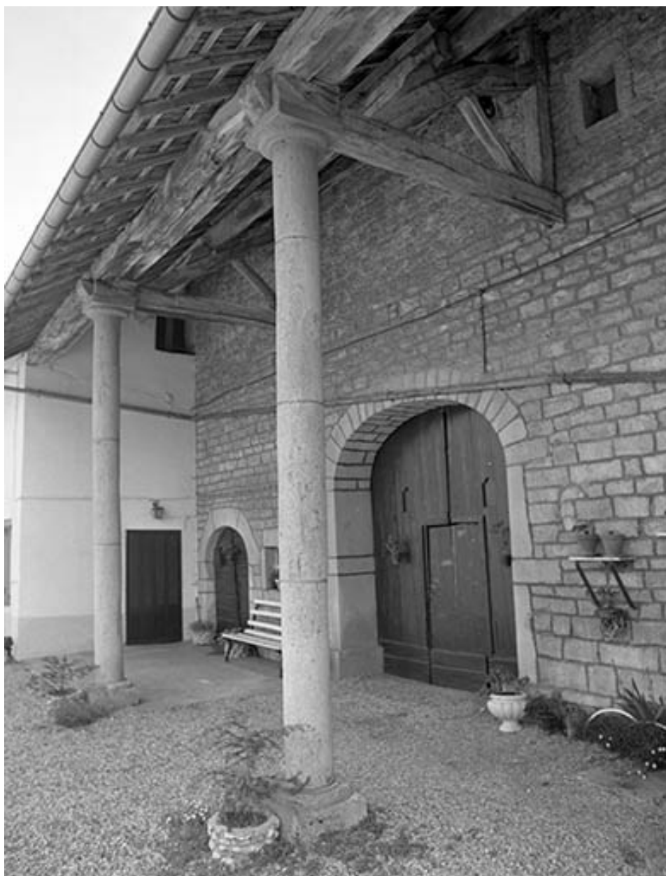
Façade antérieure : détail de l'avant-toit.
