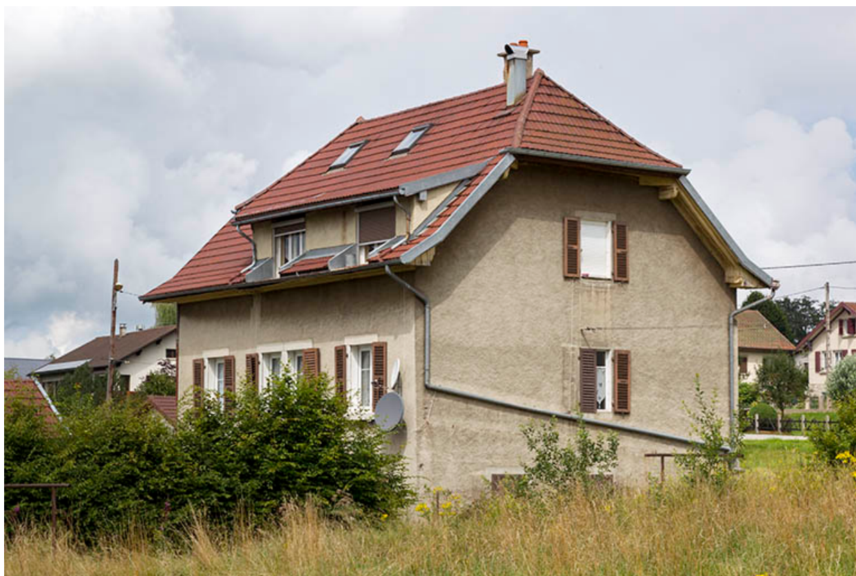
Façades postérieure et latérale gauche.
