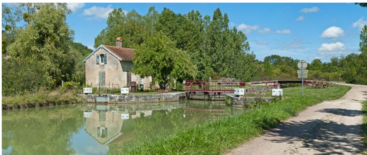
Vue d'ensemble du site d'écluse.
