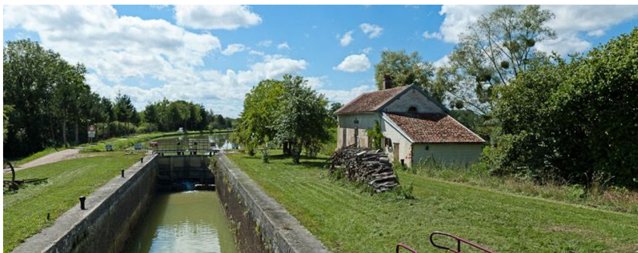
Vue d'ensemble du site d'écluse.
