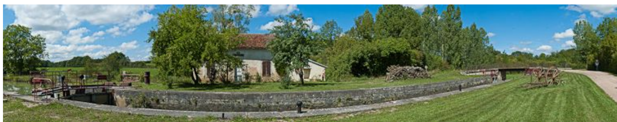
Vue d'ensemble du site d'écluse.
