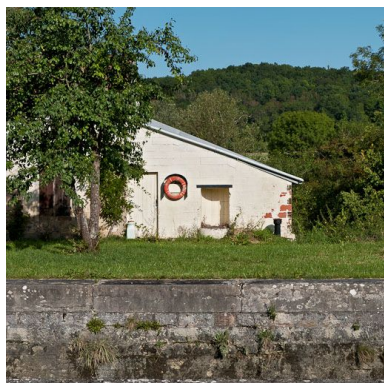
Vue de l'extension latérale. Phot. Pierre-Marie Barbe-Richaud IVR26_20112103794NUC2AQ
