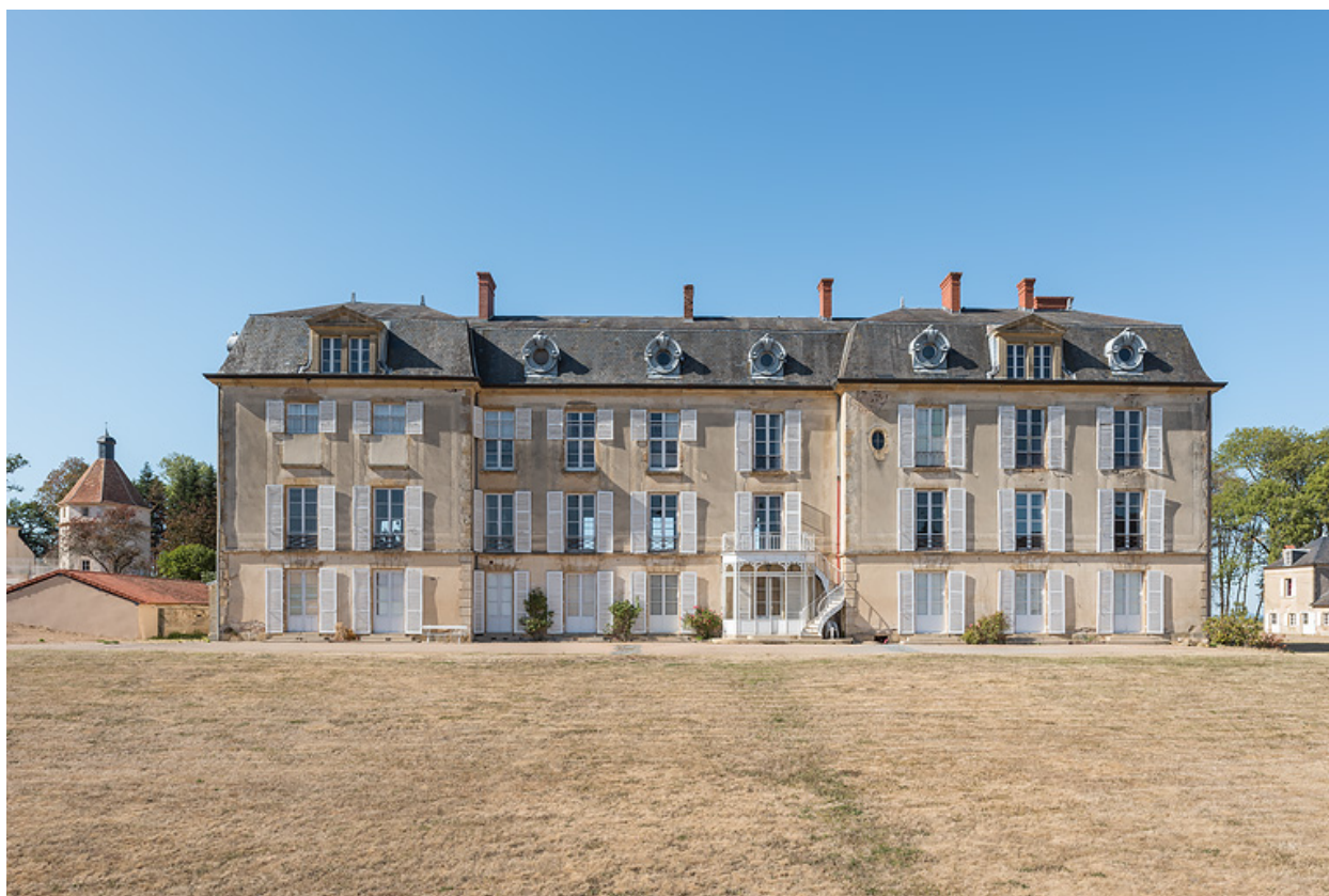
Façade sur le parc, vue de face.
