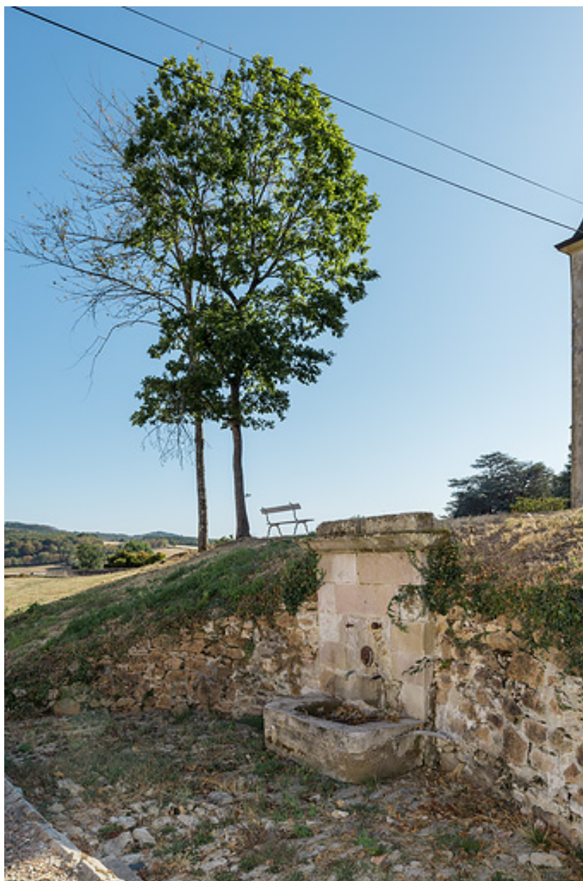
Fontaine-abreuvoir à proximité de l'écurie.
