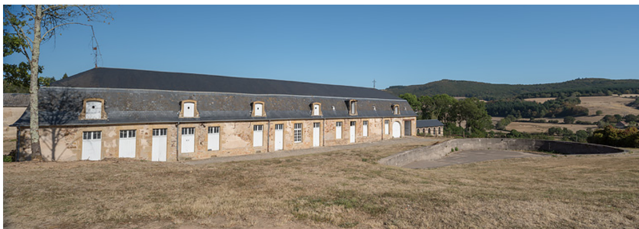
Bâtiment de l'ancienne écurie, vue depuis l'ouest.
