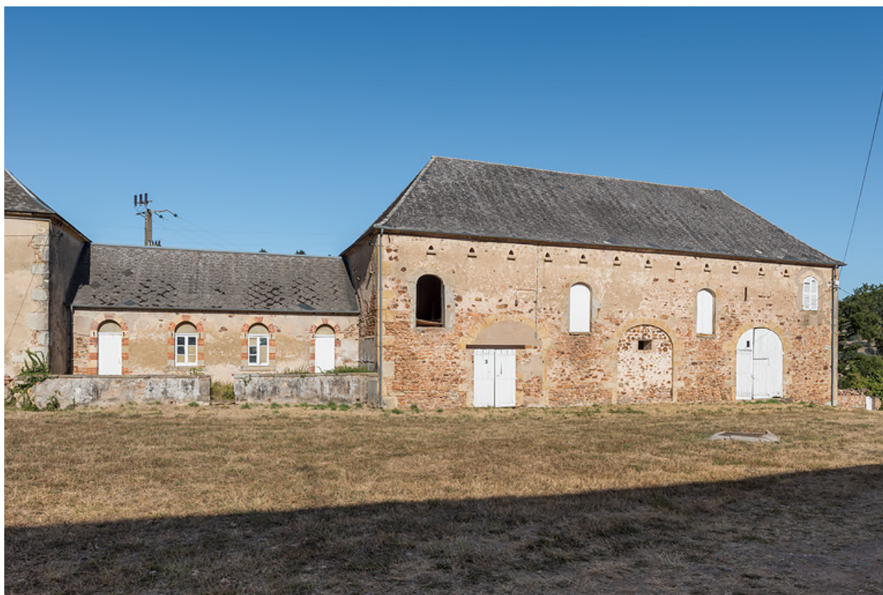
Bâtiment des dépendances.
