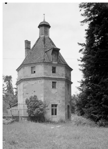
Colombier, vue prise en 1977. Phot. Jean-Luc Duthu IVR26_19775800605V
