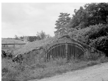
Cellier, vue prise en 1977. Phot. Jean-Luc Duthu IVR26_19775800606V
