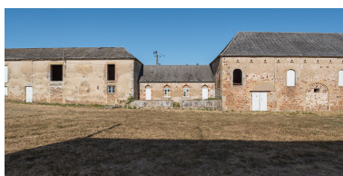
Bâtiment des dépendances. Phot. Pierre-Marie Barbe-Richaud IVR26_20195800711NUC4AQ
