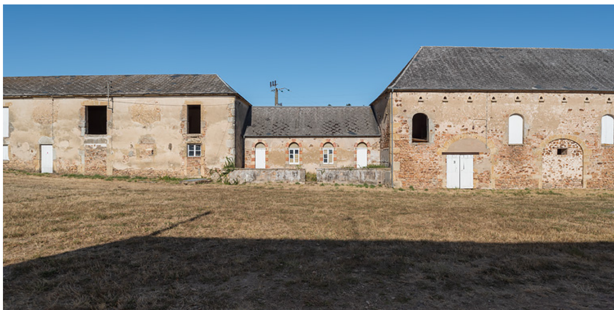
Bâtiment des dépendances.
