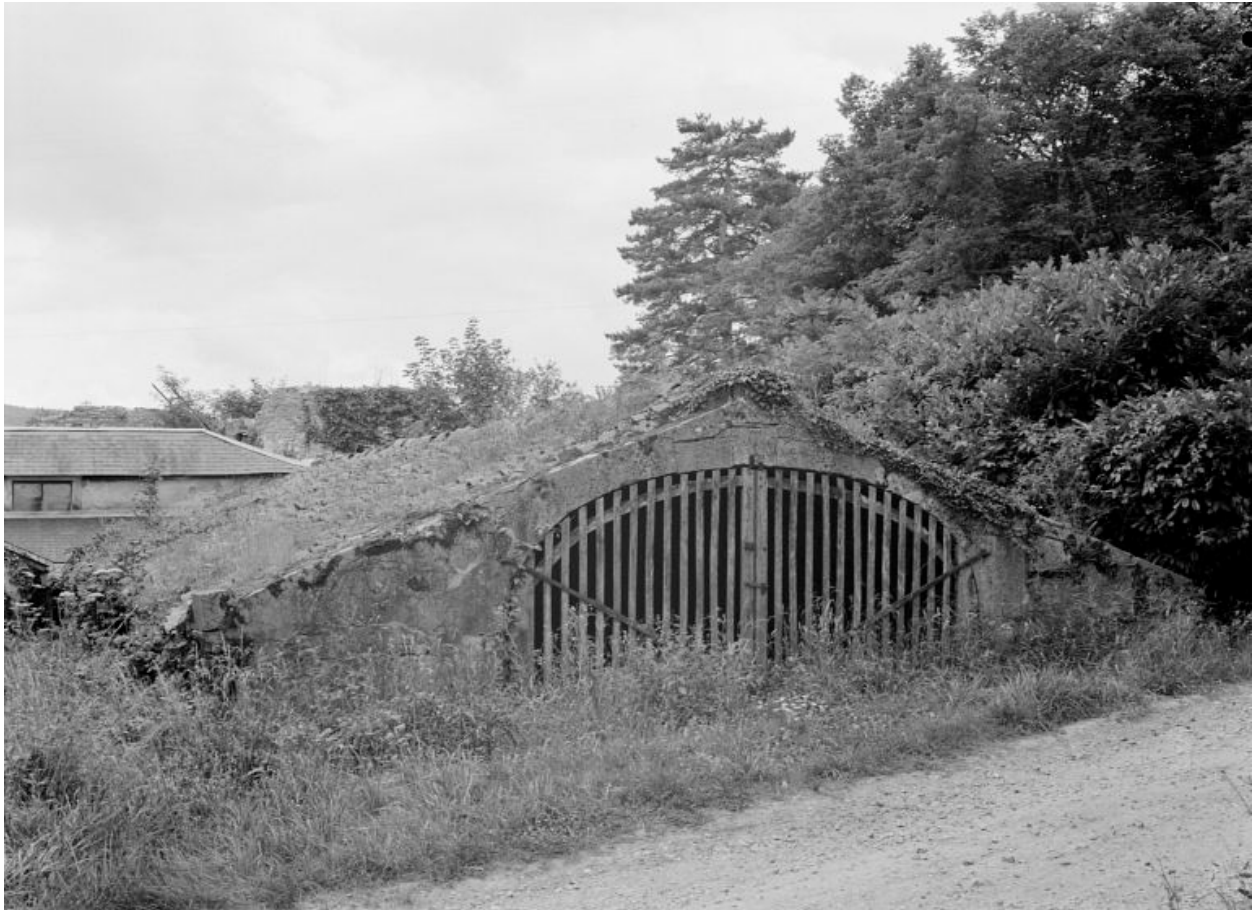
Cellier, vue prise en 1977.
