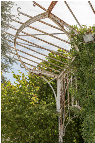
Détail : marquise. Phot. Pierre-Marie Barbe-Richaud IVR26_20195800610NUC4A
