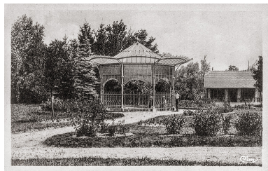
Vue ancienne. Autr. auteur inconnu IVR26_20195800725NUC4A
