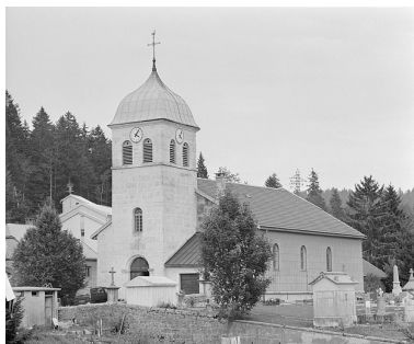
Façade ouest et face sud. Phot. Yves Sancey IVR43_19963900935X
