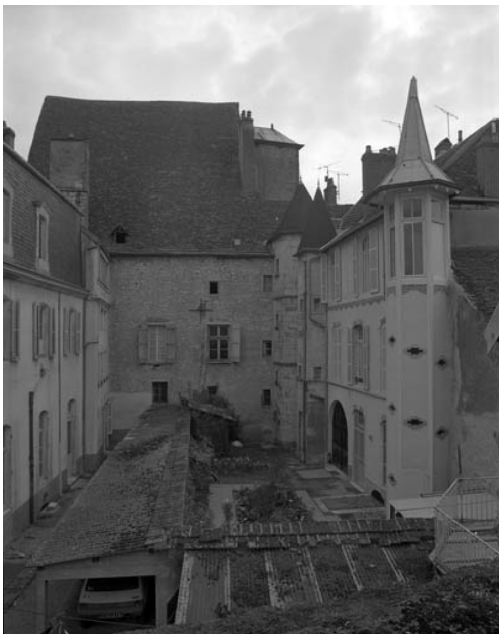
Façade latérale gauche : vue éloignée.
