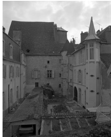
Façade latérale gauche : vue éloignée.
