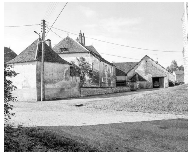
Vue d'ensemble : façade postérieure. Phot. Dominique Dominguez IVR43_19807000416X
