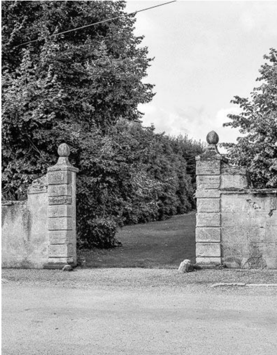
Portail d'entrée principal.
