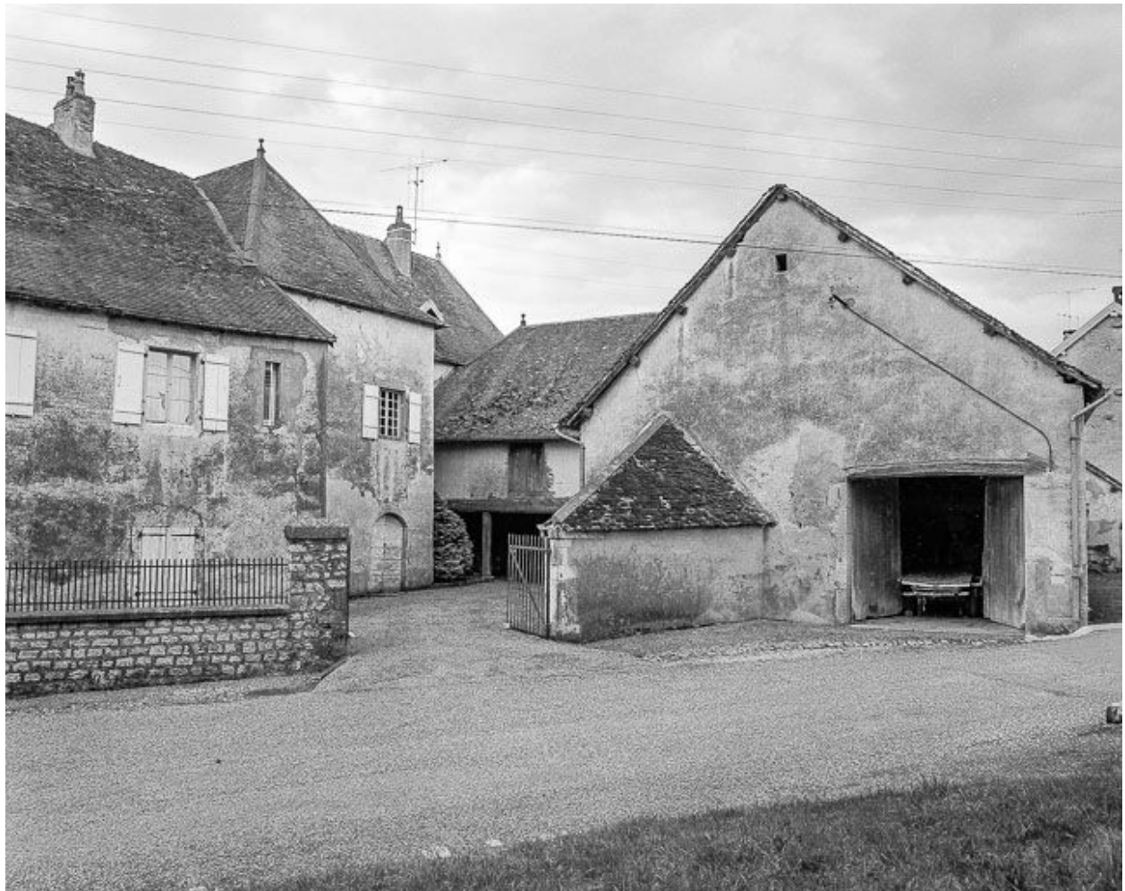
Façade postérieure : cour et remises.
