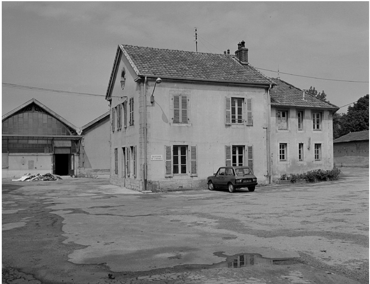
Pavillon d'entrée droit.
