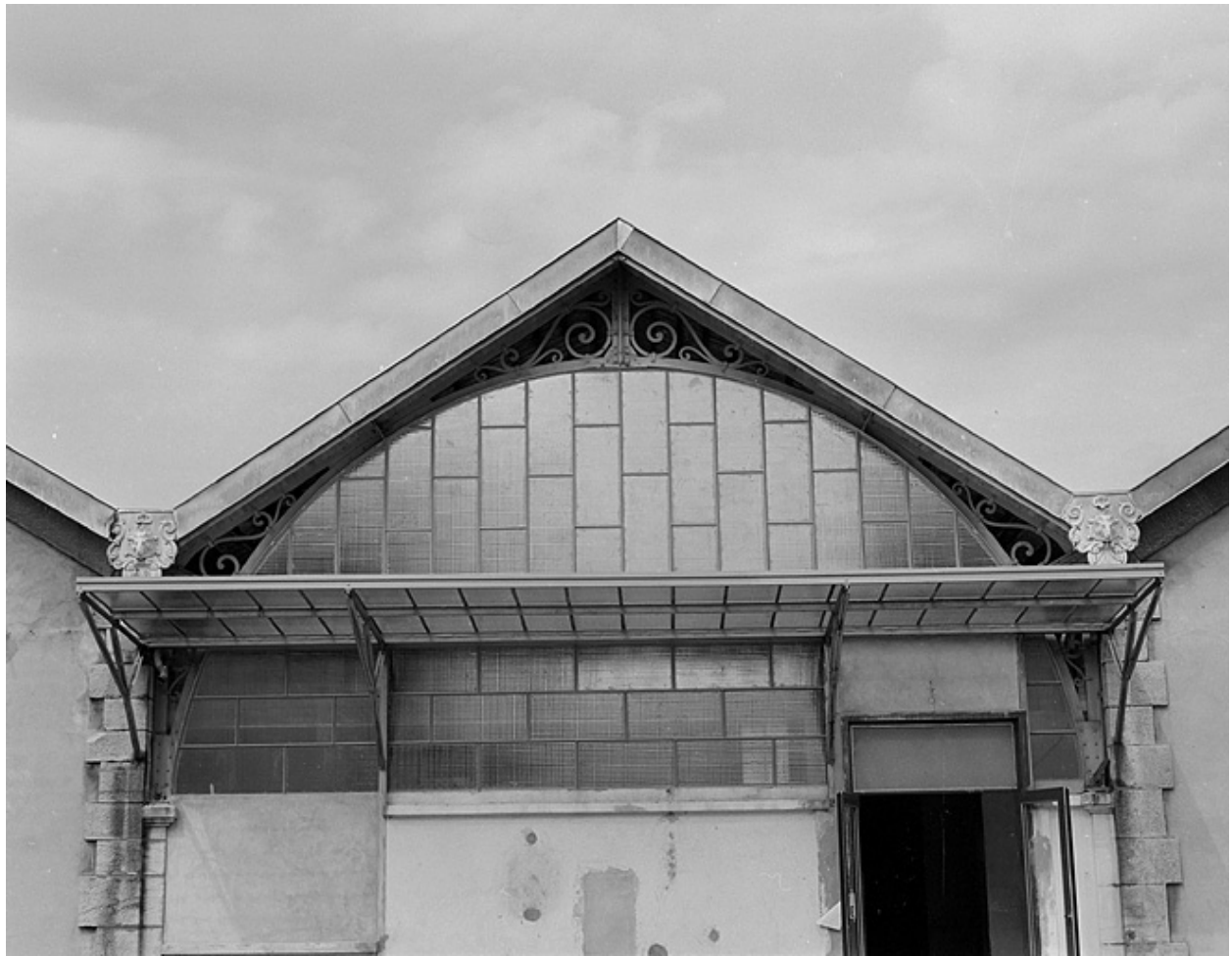
Détail de la couverture de la halle.
