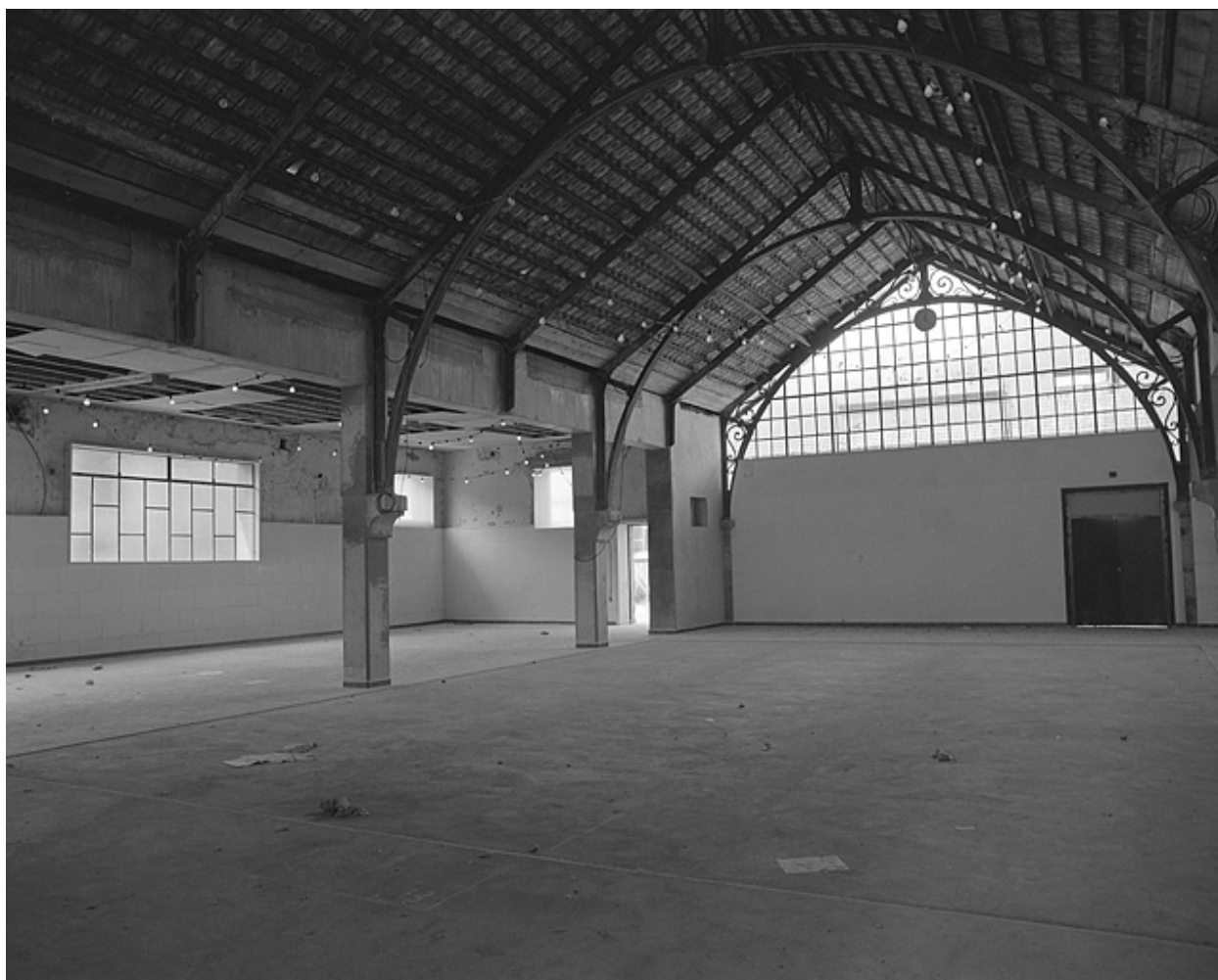
Vue intérieure de la halle.
