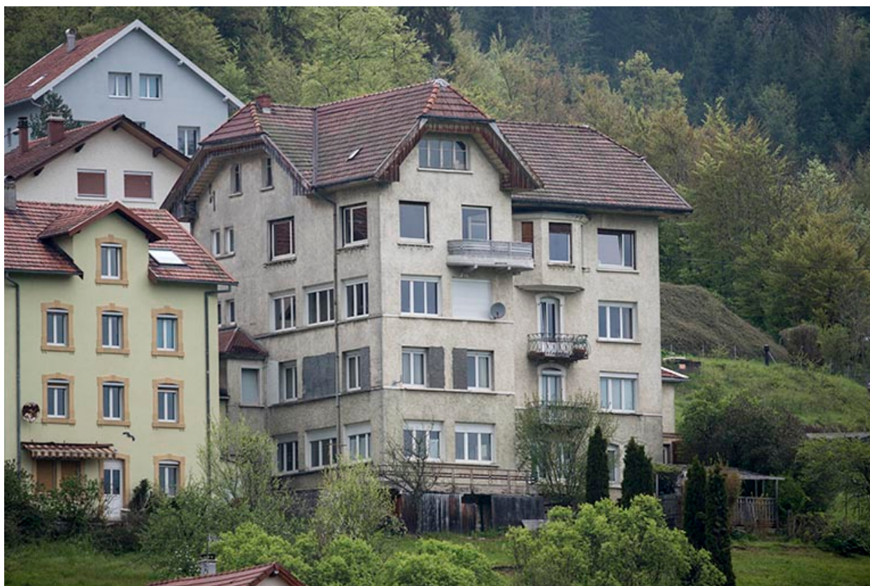
Façades postérieure et latérale droite.
