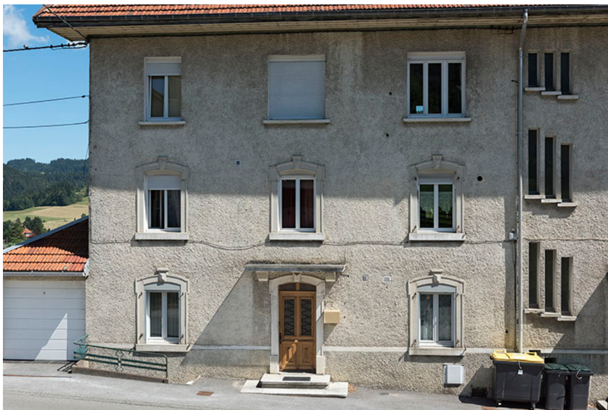
Façade antérieure : partie gauche.
