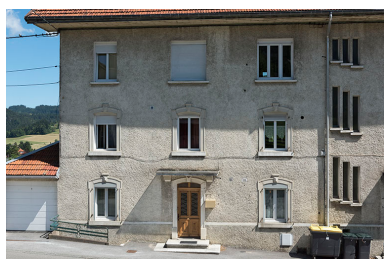
Façade antérieure : partie gauche. Phot. Sonia Dourlot IVR43_20162500902NUC4A
