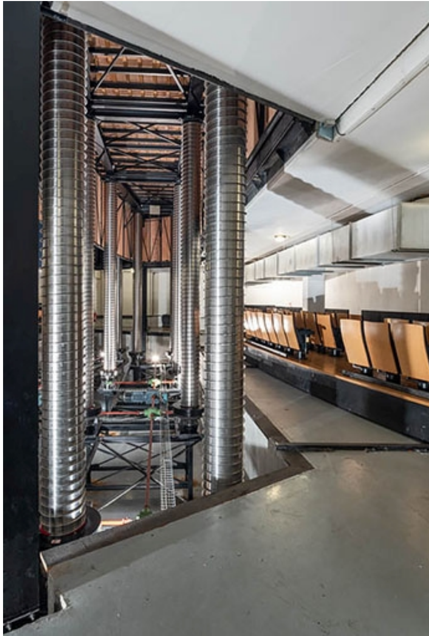
Avant-scène : colonnes Spiralift soutenant le plancher de la fosse d'orchestre (cadrage vertical).
