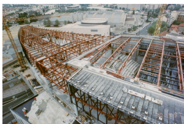
Construction : charpente métallique de la salle et du corps enjambant l'avenue de Champagne. 30 avril 1997.
