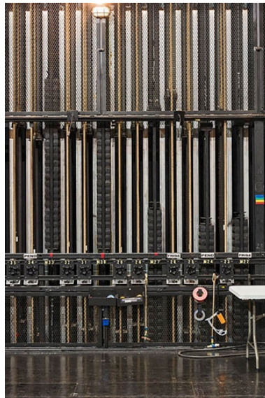
Cage de scène : fils de commande des perches et contrepoids ("équipe contrebalancée"). Phot. Pierre-Marie Barbe-Richaud IVR26_20212100133NUC4A
