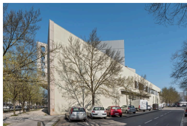
Elévation sur le boulevard de Verdun (est), vue de trois quarts gauche. Phot. Pierre-Marie Barbe-Richaud IVR26_20222100172NUC4A
