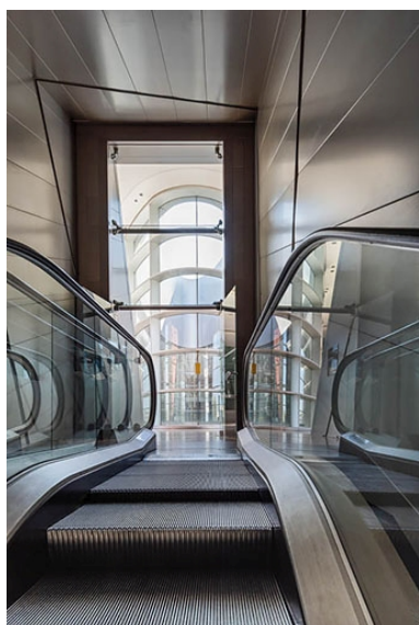
Escalier mécanique principal : arrivée dans le hall. Phot. Pierre-Marie Barbe-Richaud IVR26_20212100191NUC4A
