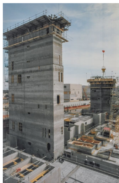
Construction des tours pour les circulations verticales et les gaines. Début 1996. Autr. auteur inconnu IVR26_20212100280NUC2A
