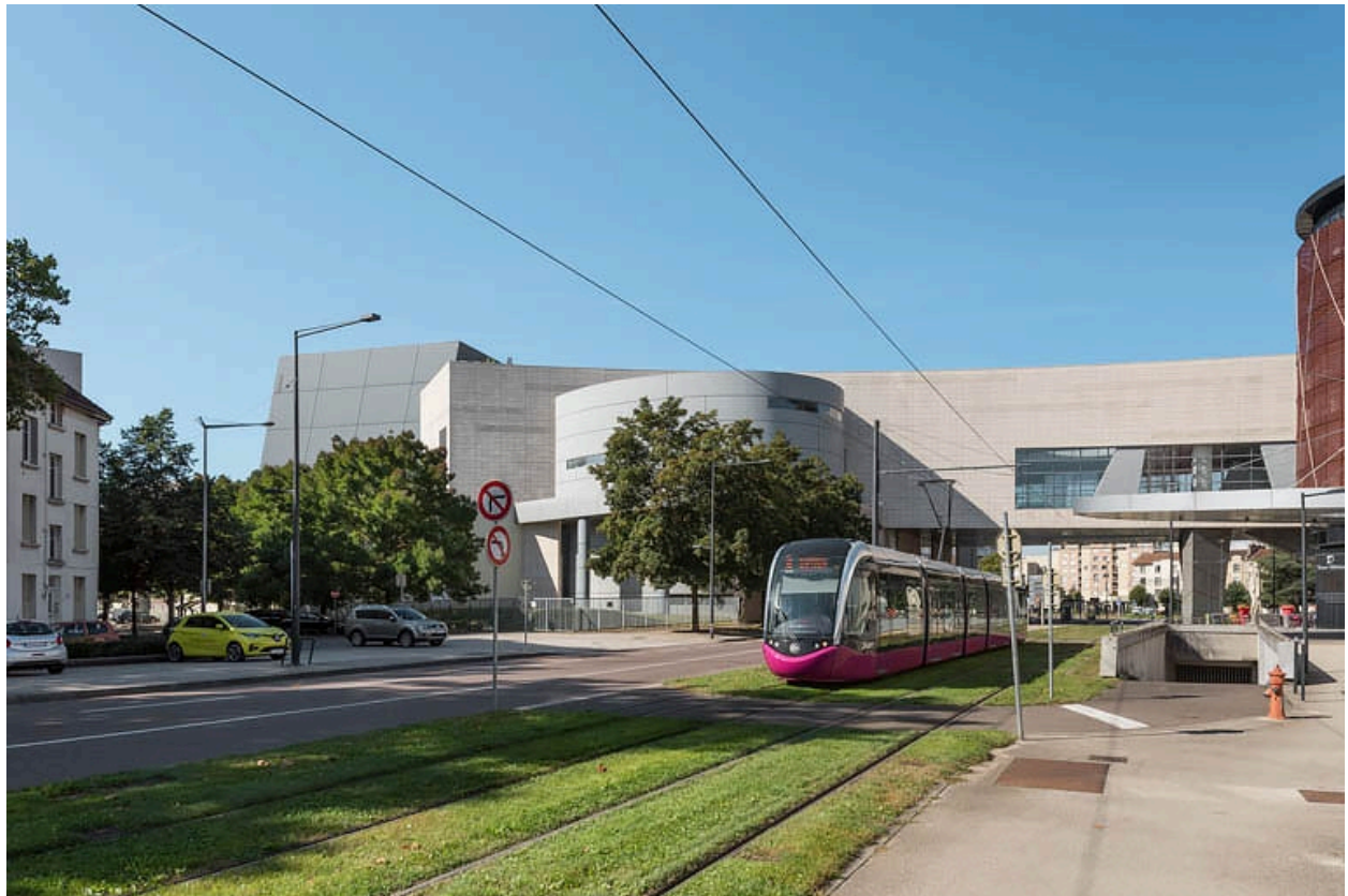
Vue d'ensemble depuis l'est, avec tramway.
