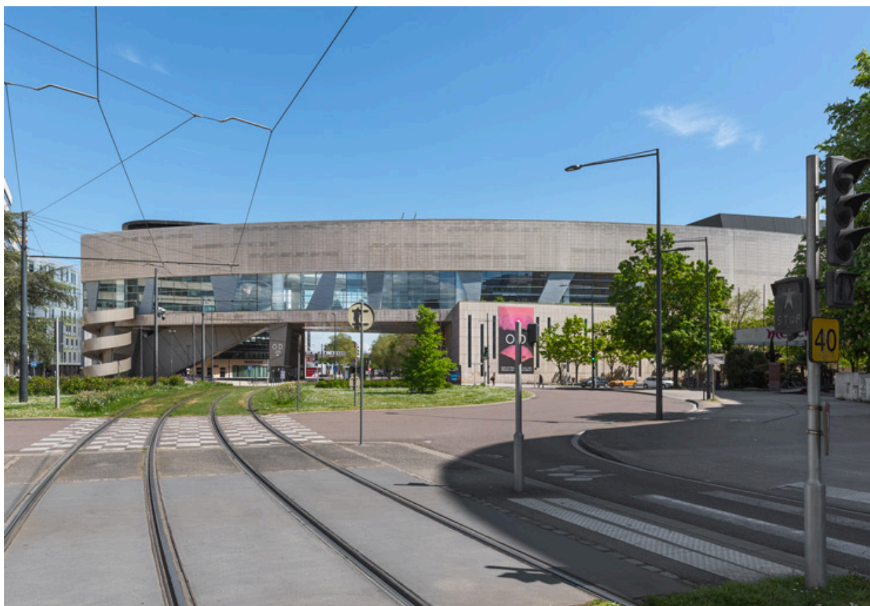
Vue d'ensemble (rapprochée), depuis l'ouest.
