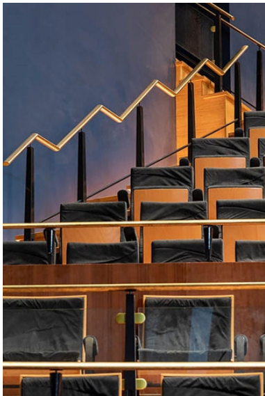
Maîtrise de l'acoustique : main courante en dents de scie. Phot. Pierre-Marie Barbe-Richaud IVR26_20212100137NUC4A
