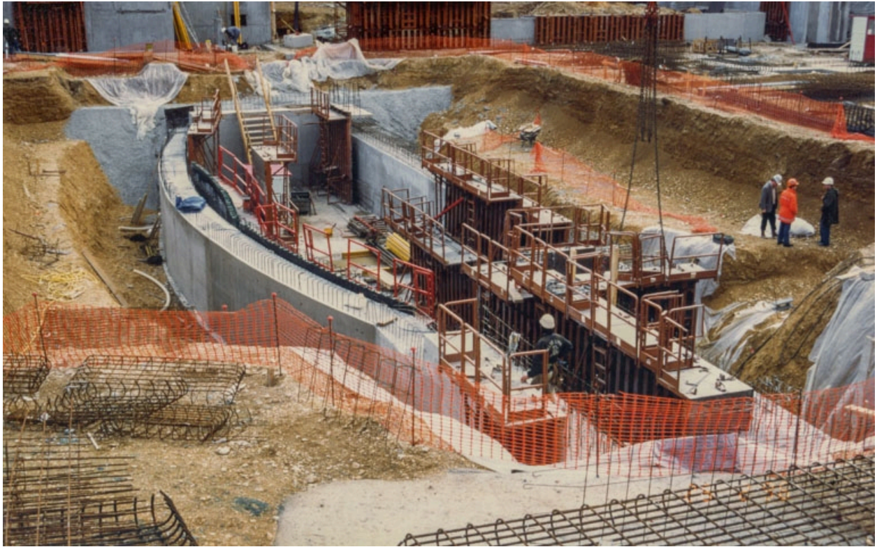
Construction de la fosse d'orchestre. 26 février 1996.
