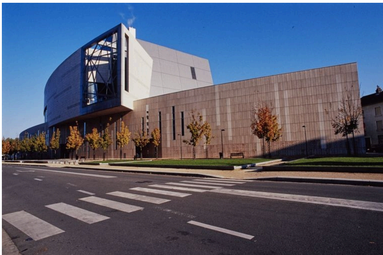
Elévation latérale, boulevard de Verdun, en 2001.
