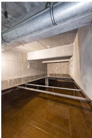
Bassin en sous-sol (350 m3). Phot. Pierre-Marie Barbe-Richaud IVR26_20212100165NUC4A
