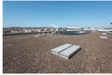
Toit terrasse au-dessus de la salle. Phot. Pierre-Marie Barbe-Richaud IVR26_20212100160NUC4A
