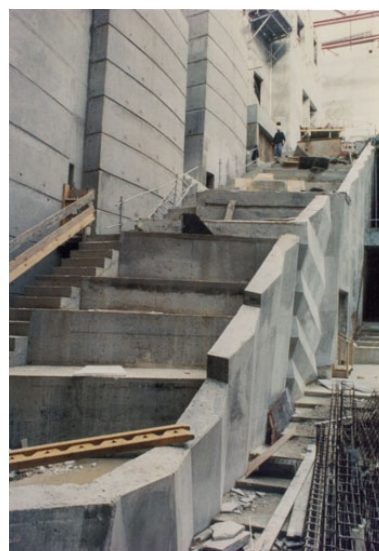
Construction : escalier et balcon latéral de la salle ("plateau latéral côté cour"). Début 1997.
