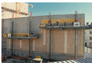
Construction : isolation d'un mur. 1er avril 1997.
