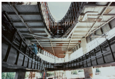
Construction : puits de lumière, vu du sol. S.d. [mi 1997 ?]. Autr. auteur inconnu IVR26_20212100300NUC2A
