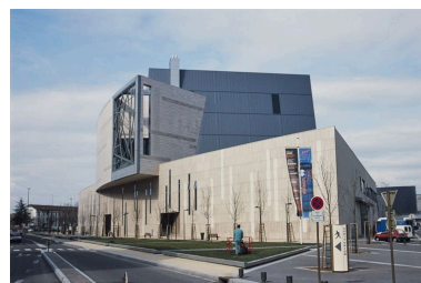
Elévation postérieure, boulevard de Verdun, en 2000. Phot. Jean-Luc Duthu IVR26_20002100530ZA
