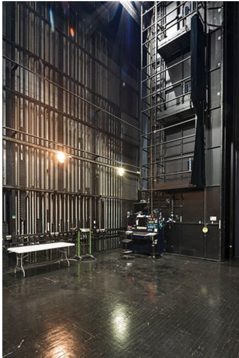
Cage de scène : fils de commande des perches en coulisse.
