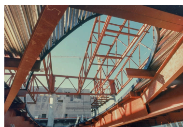
Construction : charpente métallique supportant le puits de lumière, vue du sol. 1er avril 1997.
