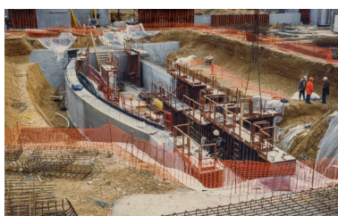
Construction de la fosse d'orchestre, 26 février 1996. Autr. auteur inconnu IVR26_20212100279NUC4A
