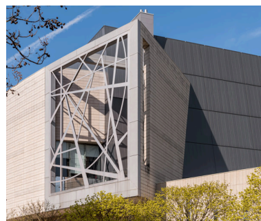
Elévation latérale depuis le sud : terrasse avec sculpture métallique et cage de scène. Phot. Pierre-Marie Barbe-Richaud IVR26_20262100194NUC2A
