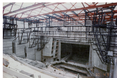
Construction : passerelles, structures métalliques des réflecteurs accoustiques et cadre de scène. 30 avril 1997.
