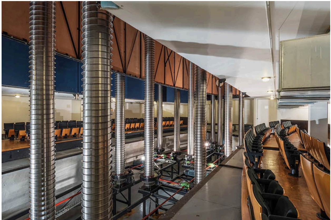
Avant-scène : colonnes Spiralift soutenant le plancher de la fosse d'orchestre. A droite et à gauche, rangées de sièges supplémentaires.
