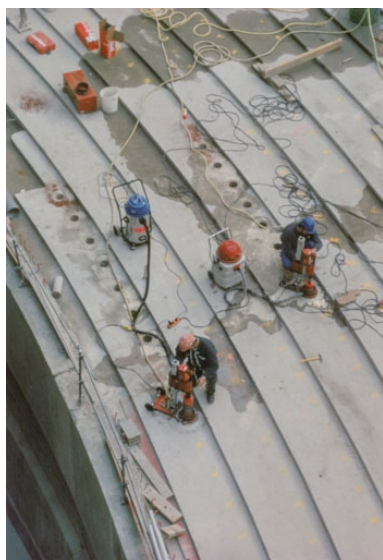
Construction : carottage des conduits de ventilation des fauteuils. 1er avril 1997 (?).
