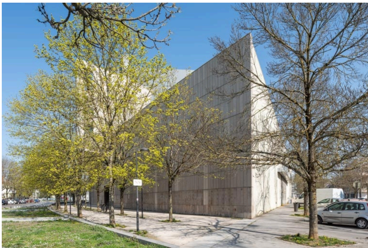
Vue d'ensemble rapprochée, depuis le sud.
