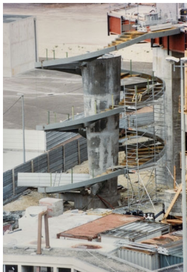
Construction : escalier en vis nord. S.d. [mi 1997 ?]. Autr. auteur inconnu IVR26_20212100299NUC4A
