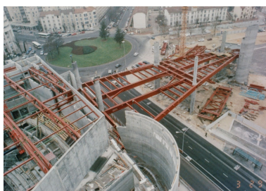
Construction : charpente métallique du corps enjambant le boulevard de Champagne. 3 février 1997.
