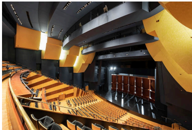
Maîtrise de l'acoustique : étagement du plafond de la salle et réflecteurs acoustiques. Phot. Pierre-Marie Barbe-Richaud IVR26_20212100124NUC4A
