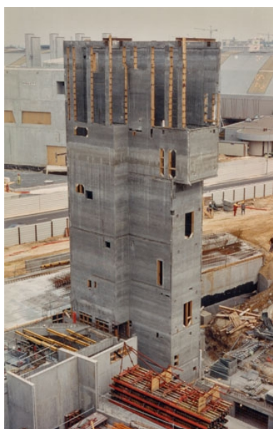
Construction de la tour nord-est pour escalier et gaine. Début 1996.
