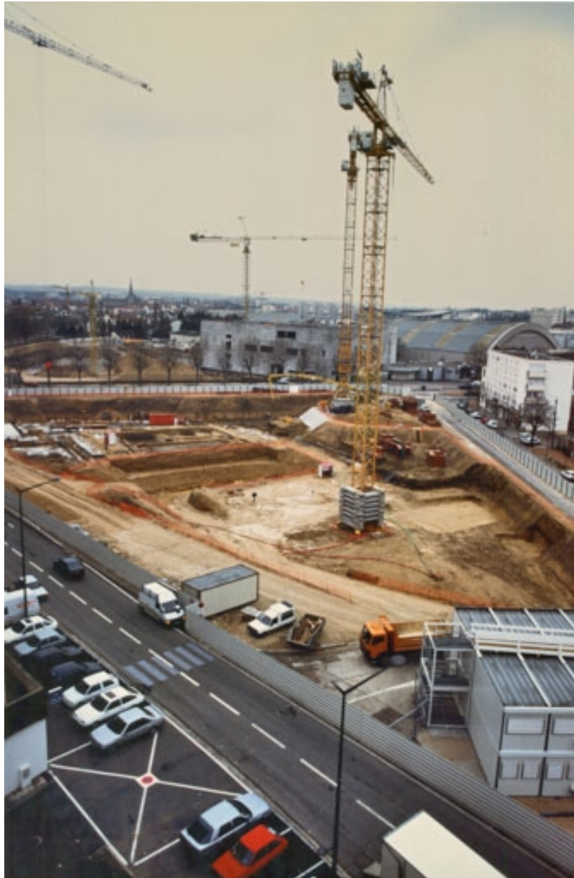
Chantier de terrassement vu du sud, début 1996. Boulevard de Champagne au 2e plan.
