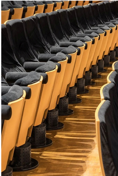
Maîtrise de l'acoustique : système de ventilation intégré au pied des fauteuils. Phot. Pierre-Marie Barbe-Richaud IVR26_20212100184NUC4A
