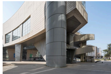
Extrémité du corps d'entrée (au nord). Phot. Pierre-Marie Barbe-Richaud IVR26_20222100176NUC4A
