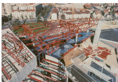
Construction : charpente métallique du corps enjambant le boulevard de Champagne. 1er avril 1997.
