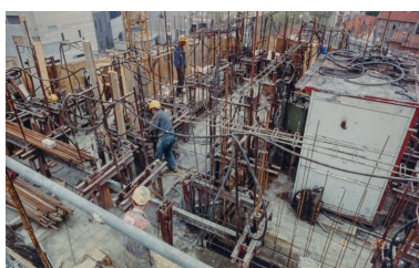
Construction : ferraillage. 29 avril 1996. Autr. auteur inconnu IVR26_20212100282NUC2A
