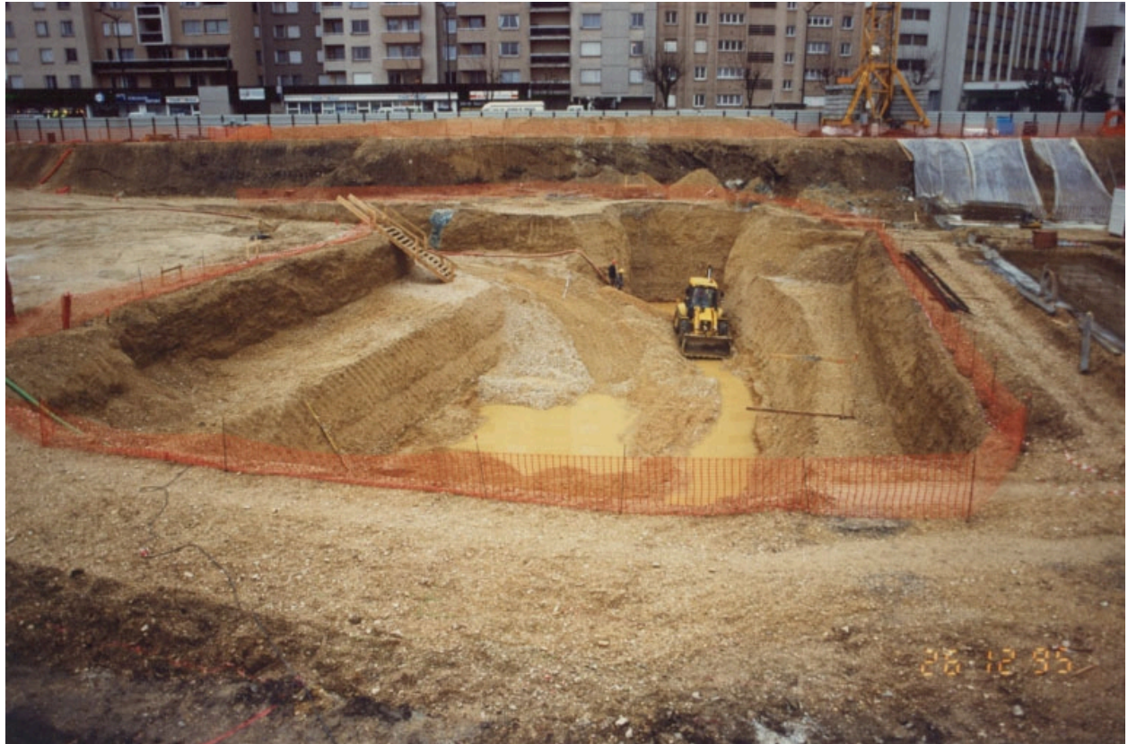
Chantier de terrassement vu de l'est, le 26 décembre 1995. Boulevard de la Marne à l'arrière-plan.
