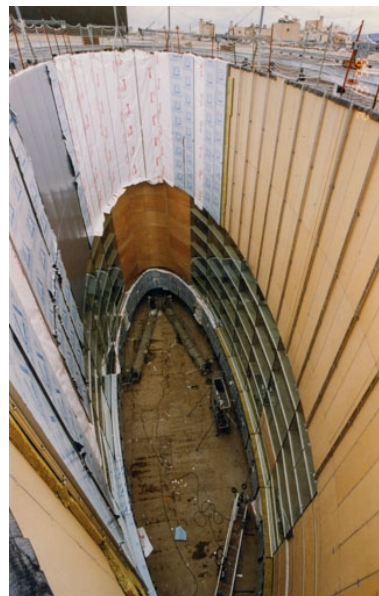
Construction : puits de lumière, vu du haut. 2 mars 1998. Autr. auteur inconnu IVR26_20212100301NUC2A
