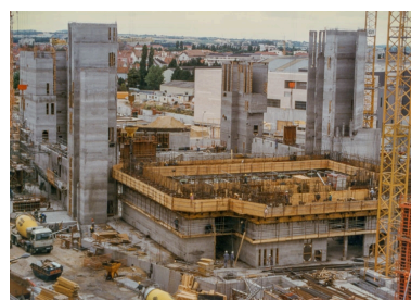
Construction : vue d'ensemble de la cage de scène, depuis le sud. 1er juillet 1996. Autr. auteur inconnu IVR26_20212100284NUC2A
