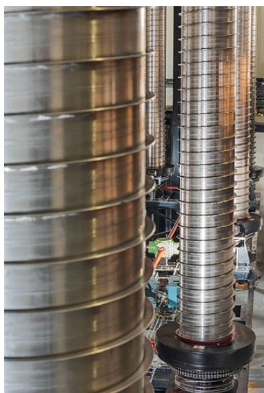
Avant-scène : colonnes Spiralift (détail). Phot. Pierre-Marie Barbe-Richaud IVR26_20212100151NUC4A
