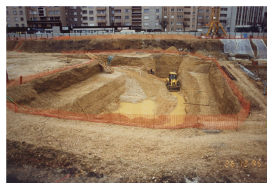
Chantier de terrassement vu de l'est, le 26 décembre 1995. Boulevard de la Marne à l'arrière-plan. Autr. auteur inconnu IVR26_20212100277NUC2A
