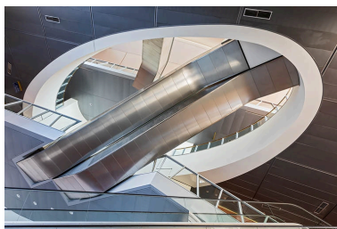
Foyer nord : escaliers mécaniques, vus en contre-plongée. Phot. Pierre-Marie Barbe-Richaud IVR26_20212100199NUC4A
