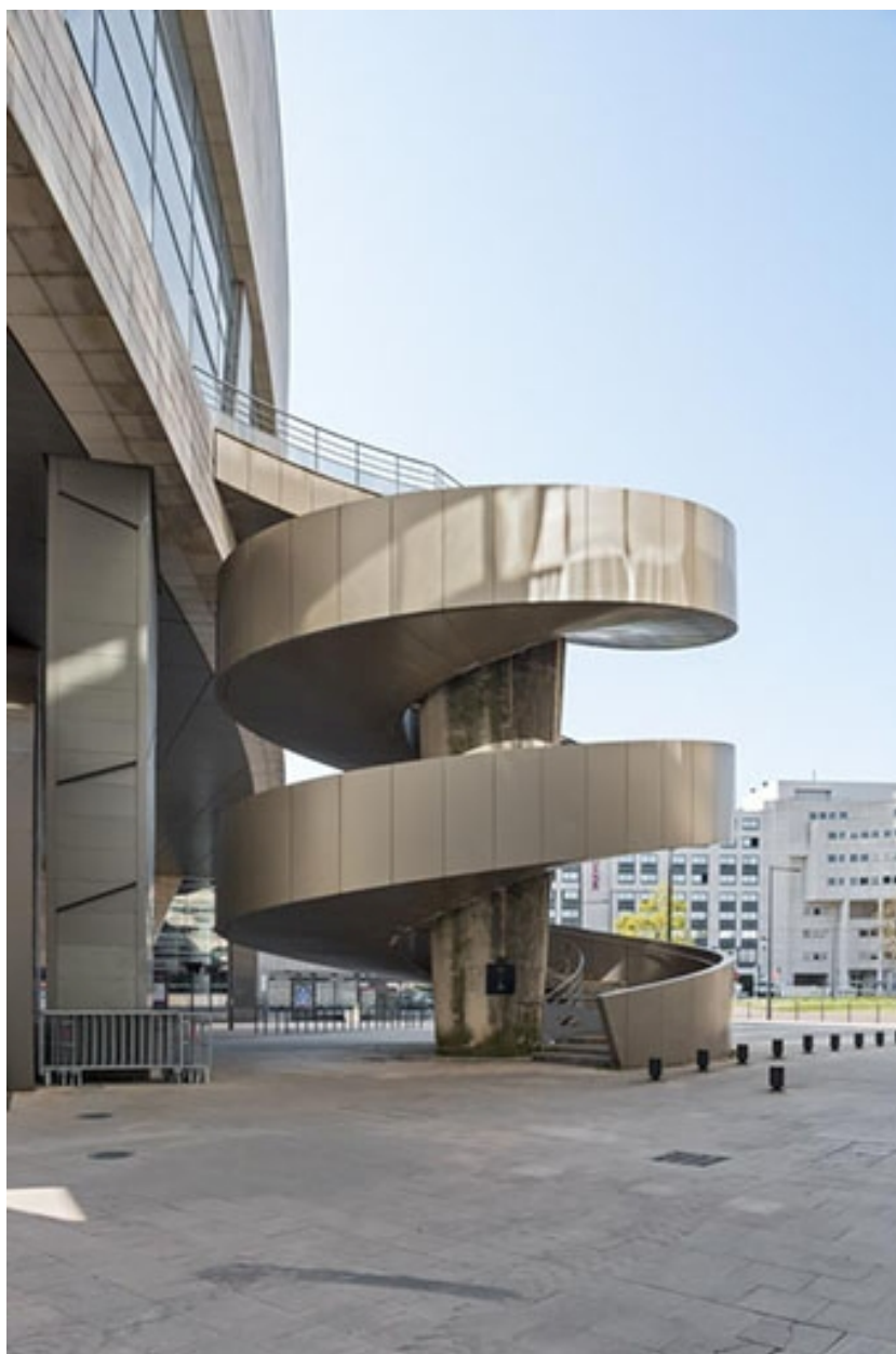
Corps d'entrée : escalier extérieur en vis.
