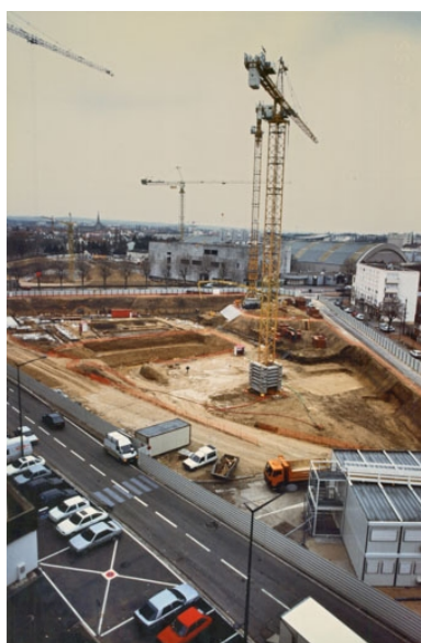
Chantier de terrassement vu du sud, début 1996. Boulevard de Champagne au 2e plan. Autr. auteur inconnu IVR26_20212100278NUC2A
