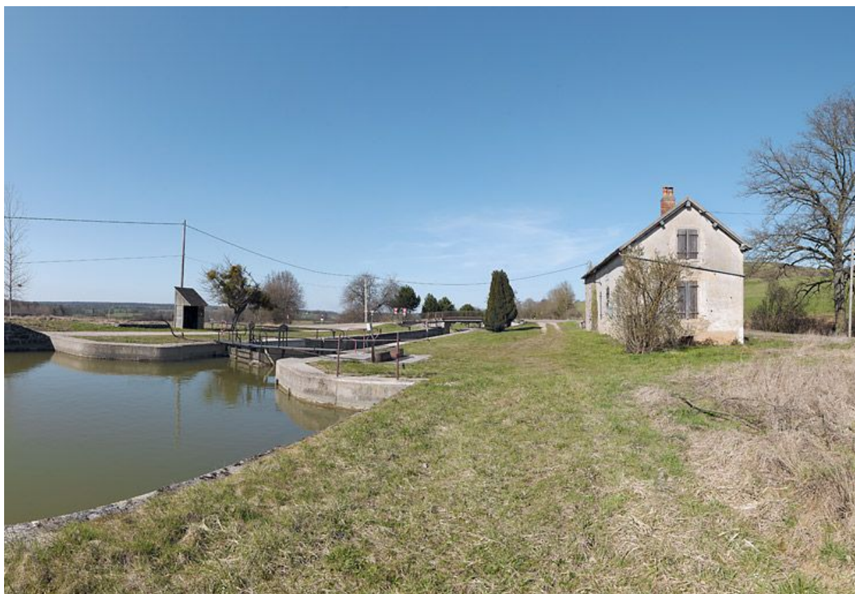
Le site d'écluse vu d'amont.
