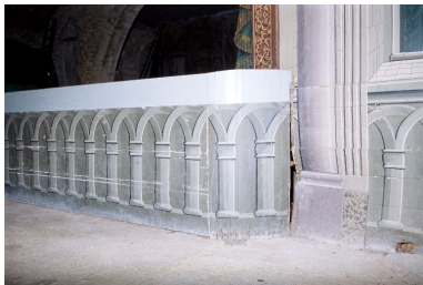
Nez-de-scène, en 2002 : détail du retour côté cour. Phot. Jean-Luc Duthu IVR26_20022100203ZA
