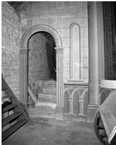
Baie côté jardin, en 2002. Phot. Jean-Luc Duthu IVR26_20022100192X
