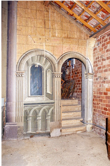
Baie côté cour, en 2002. Phot. Jean-Luc Duthu IVR26_20022100198ZA
