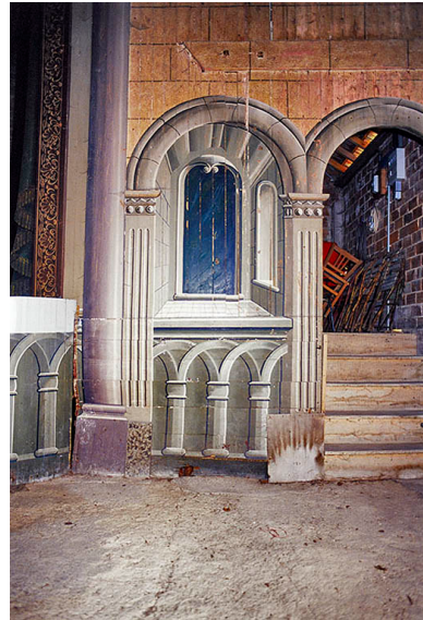
Fenêtre feinte côté cour, en 2002. Phot. Jean-Luc Duthu IVR26_20022100199ZA
