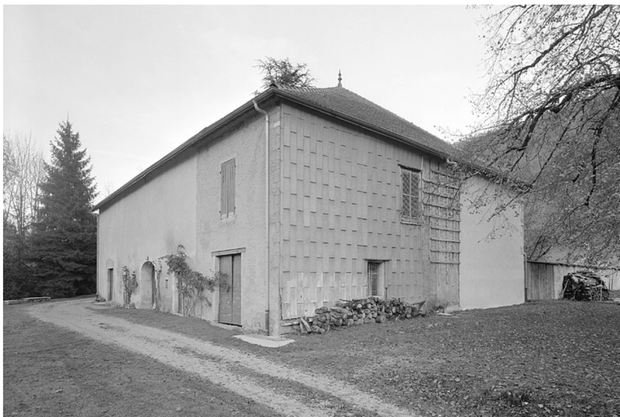
Face sud-ouest et façade postérieure.
