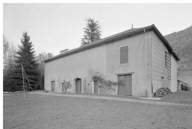
Façade postérieure. Phot. Jérôme Mongreville IVR43_19963901693V
