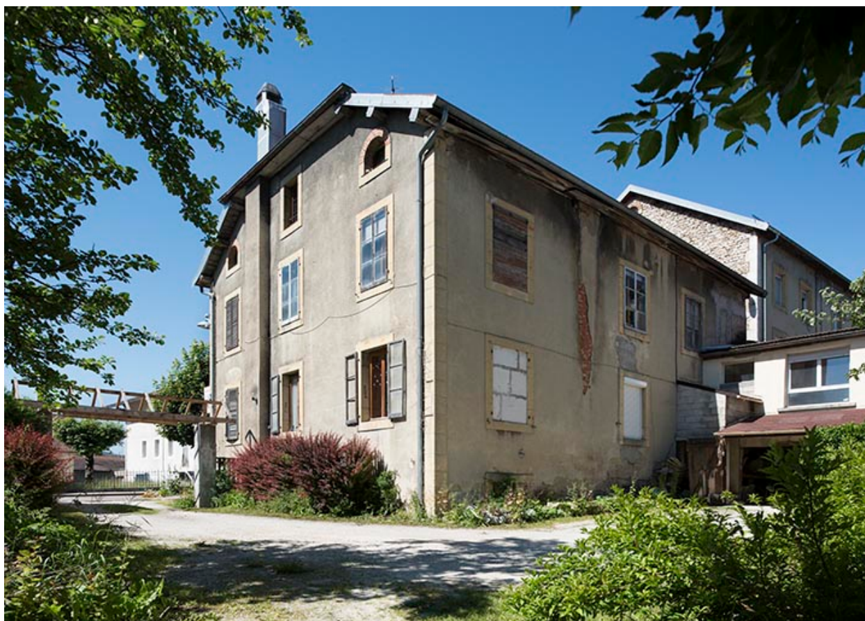
Façades postérieure et latérale droite.
