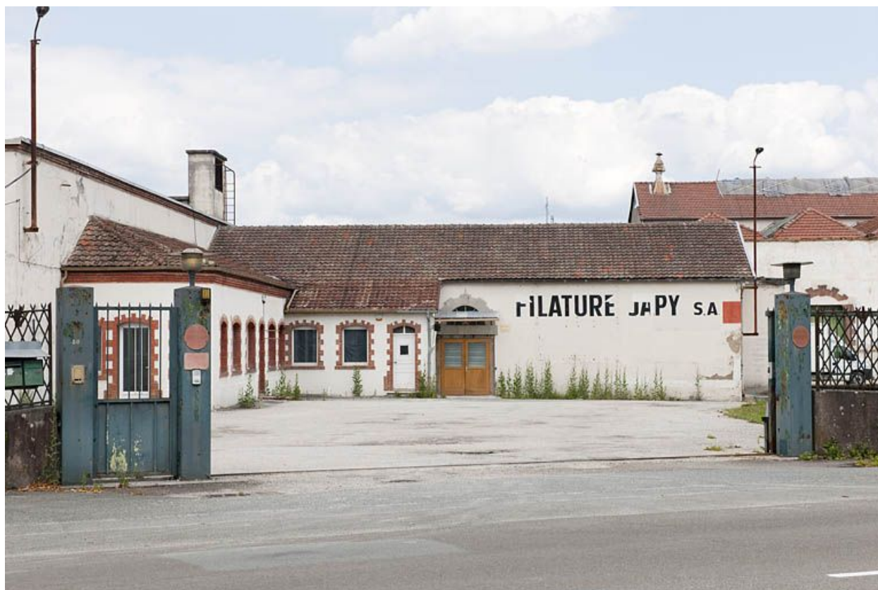
Entrée de l'usine.
