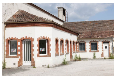
Bureaux. Phot. Jérôme Mongreville IVR43_20112501267NUC4A
