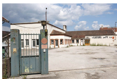
Bâtiments d'entrée. Phot. Jérôme Mongreville IVR43_20112501271NUC4A
