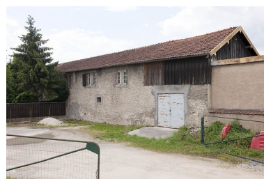
Entrepôt industriel. Phot. Jérôme Mongreville IVR43_20112501277NUC4A
