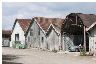
Pignons des magasins et entrepôts industriels. Phot. Jérôme Mongreville IVR43_20112501268NUC4A
