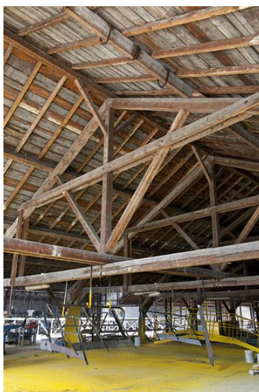
Entrepôt industriel. Charpente. Phot. Jérôme Mongreville IVR43_20112501278NUC4A
