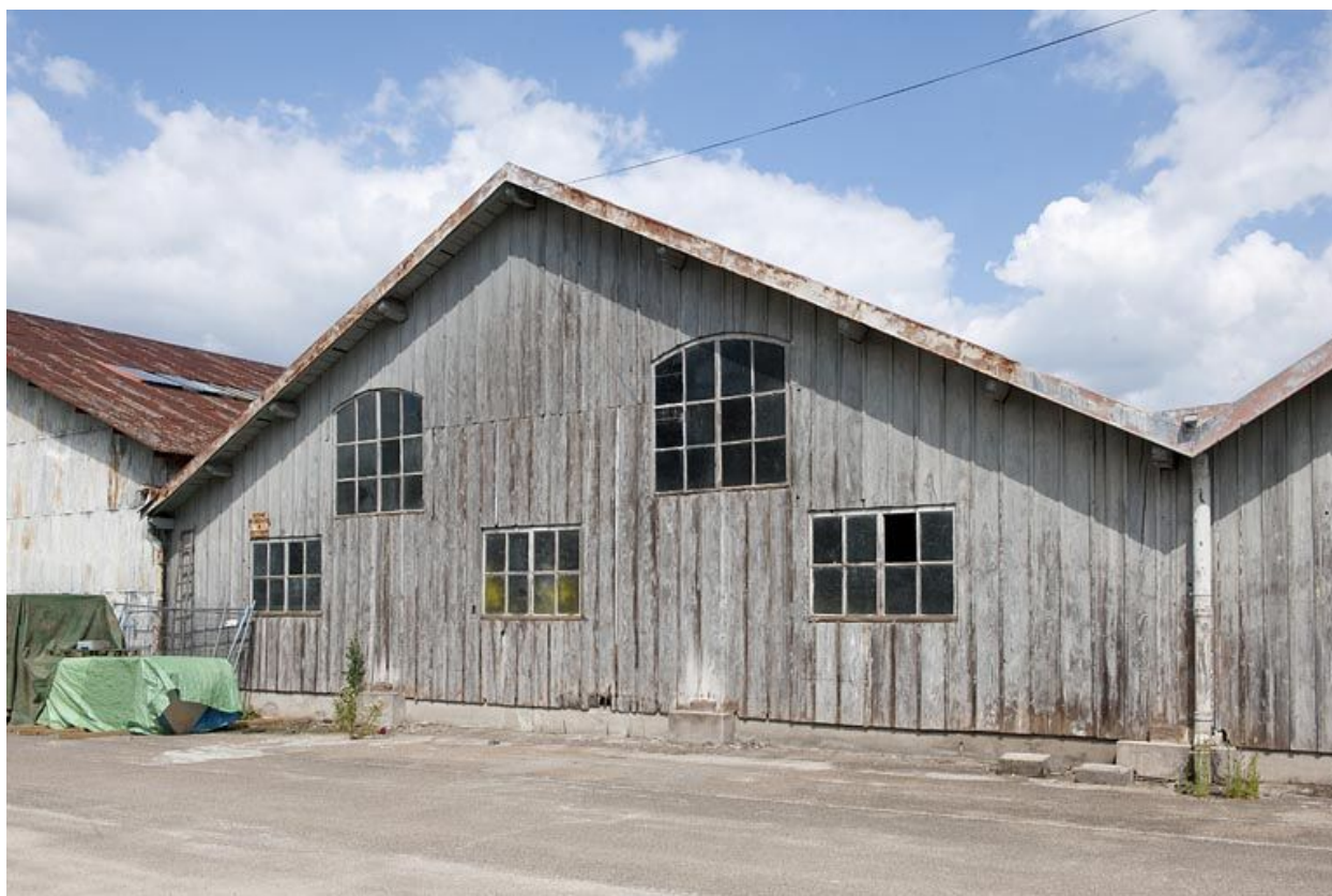
Pignon en bois d'un entrepôt industriel.
