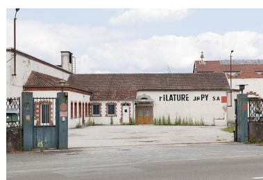
Entrée de l'usine. Phot. Jérôme Mongreville IVR43_20112501276NUC4A
