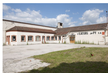
Bureaux vus depuis l'entrée. Phot. Jérôme Mongreville IVR43_20112501266NUC4A
