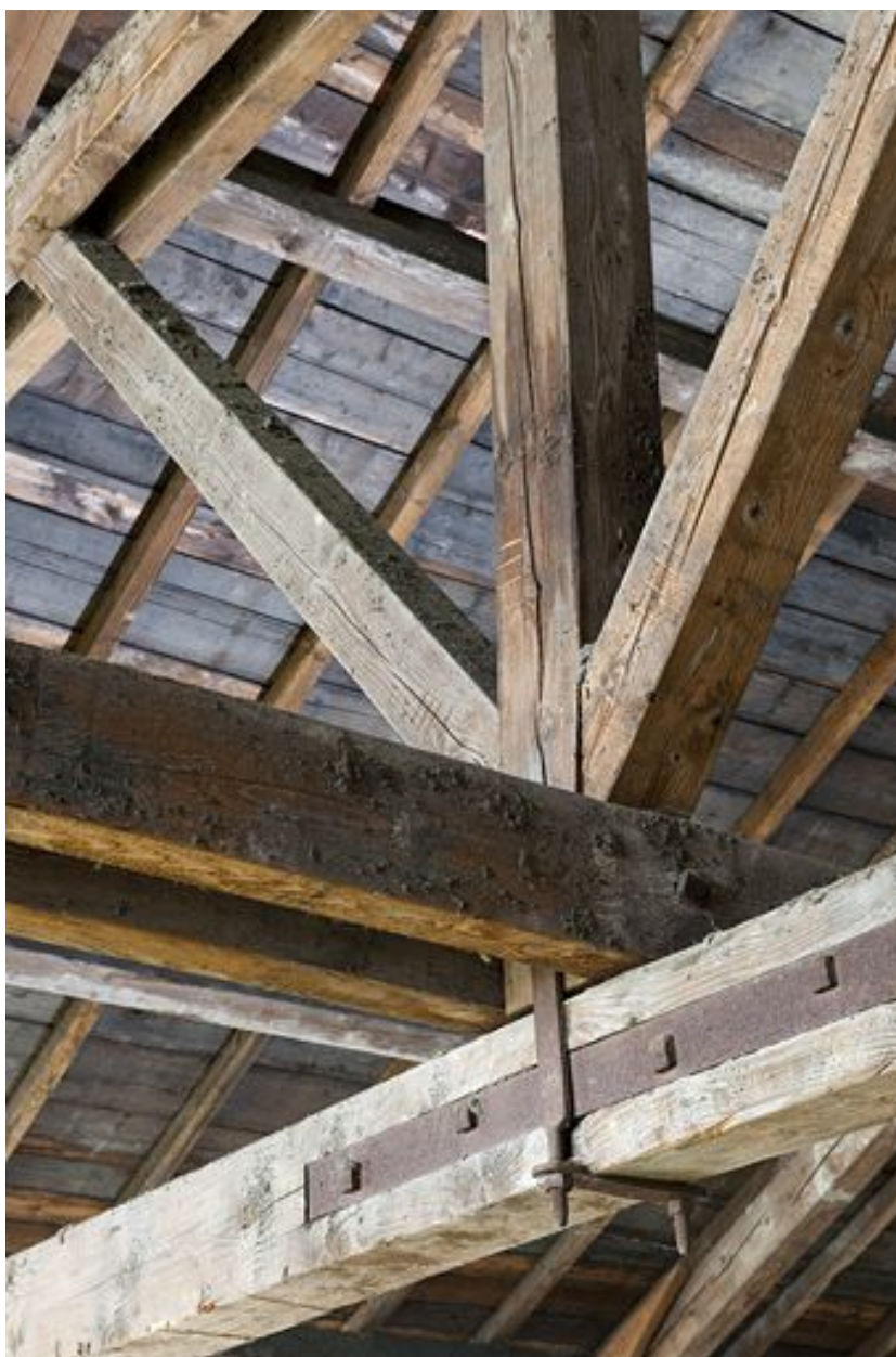
Entrepôt industriel. Charpente : jonction poinçon-entrait.
