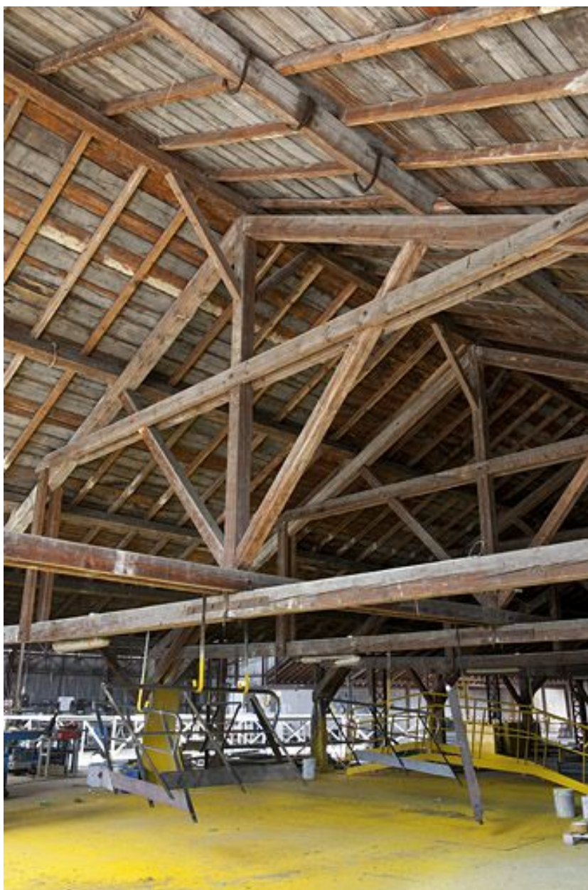
Entrepôt industriel. Charpente.
