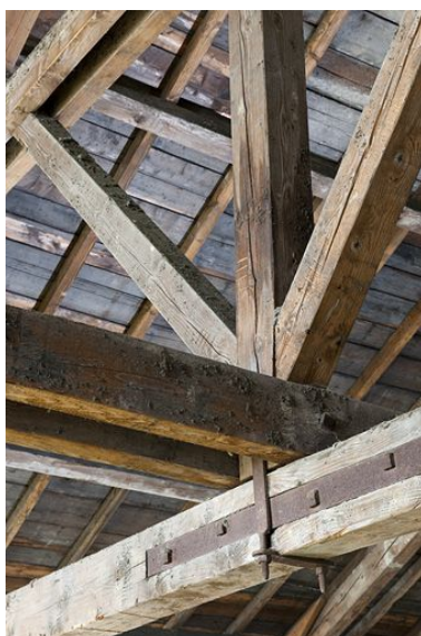
Entrepôt industriel. Charpente : jonction poinçon-entrait. Phot. Jérôme Mongreville IVR43_20112501281NUC4A
