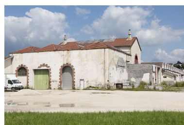
Salle des machines. Phot. Jérôme Mongreville IVR43_20112501265NUC4A
