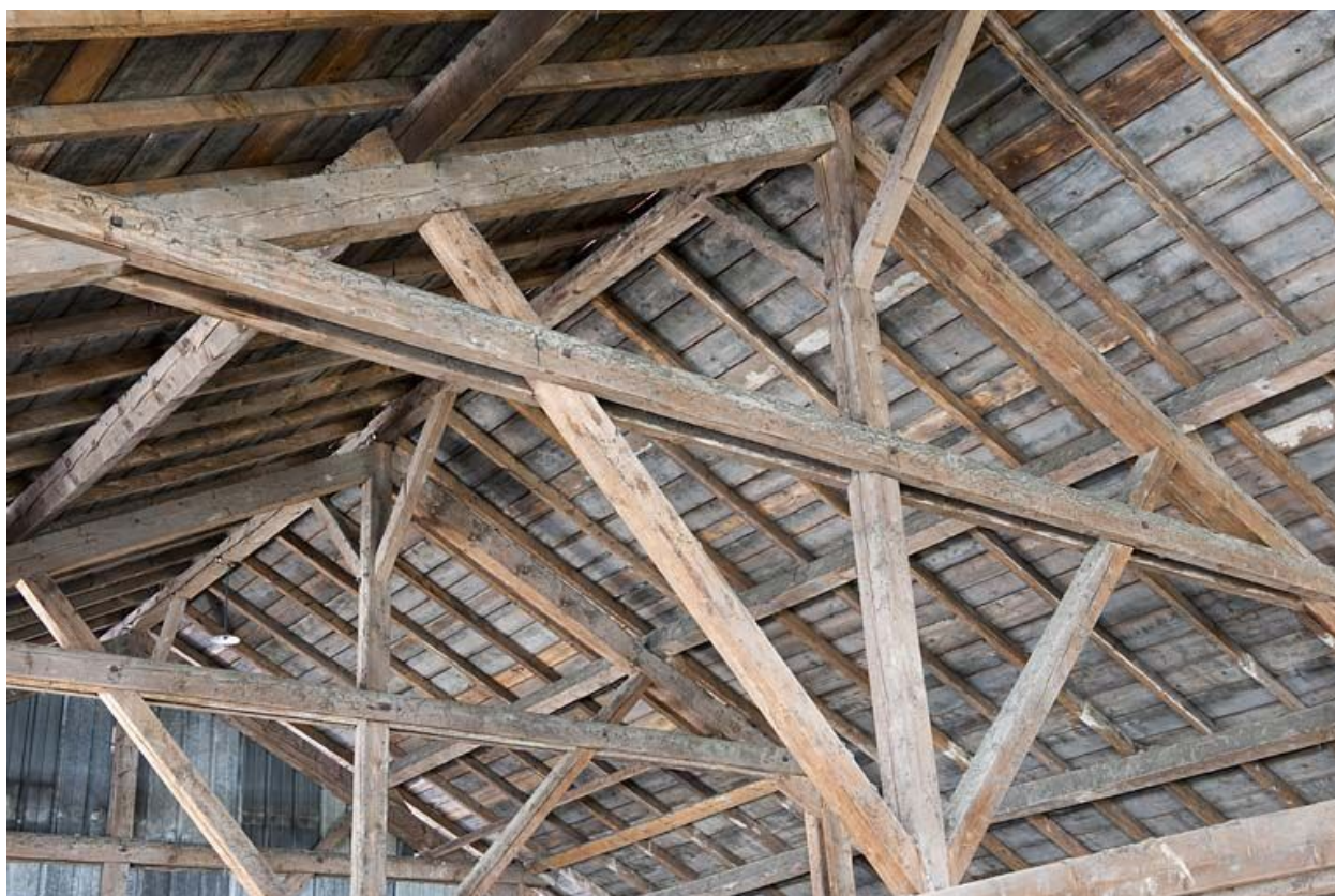
Entrepôt industriel. Détail de la charpente.
