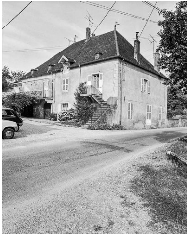
Maison de vigneron située au lieudit le Petit-Messia. Phot. Yves Sancey IVR43_19843900268X
