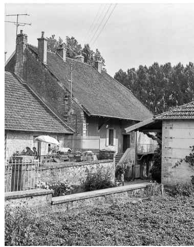
Maison de vigneron située au lieudit le Petit-Messia. Phot. Yves Sancey IVR43_19843900271X
