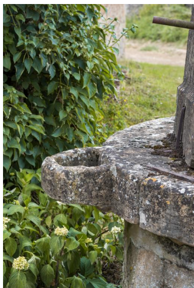
Détail du puits Phot. Pierre-Marie Barbe-Richaud IVR26_20187100162NUC4A
