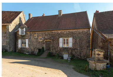
Façade antérieure de la maison. Les ruptures de l'enduit indique que le mur, en partie centrale, a été ajoutée postérieurement afin de fermer la cage d'escalier. Phot. Pierre-Marie Barbe-Richaud IVR26_20197100769NUC4A
