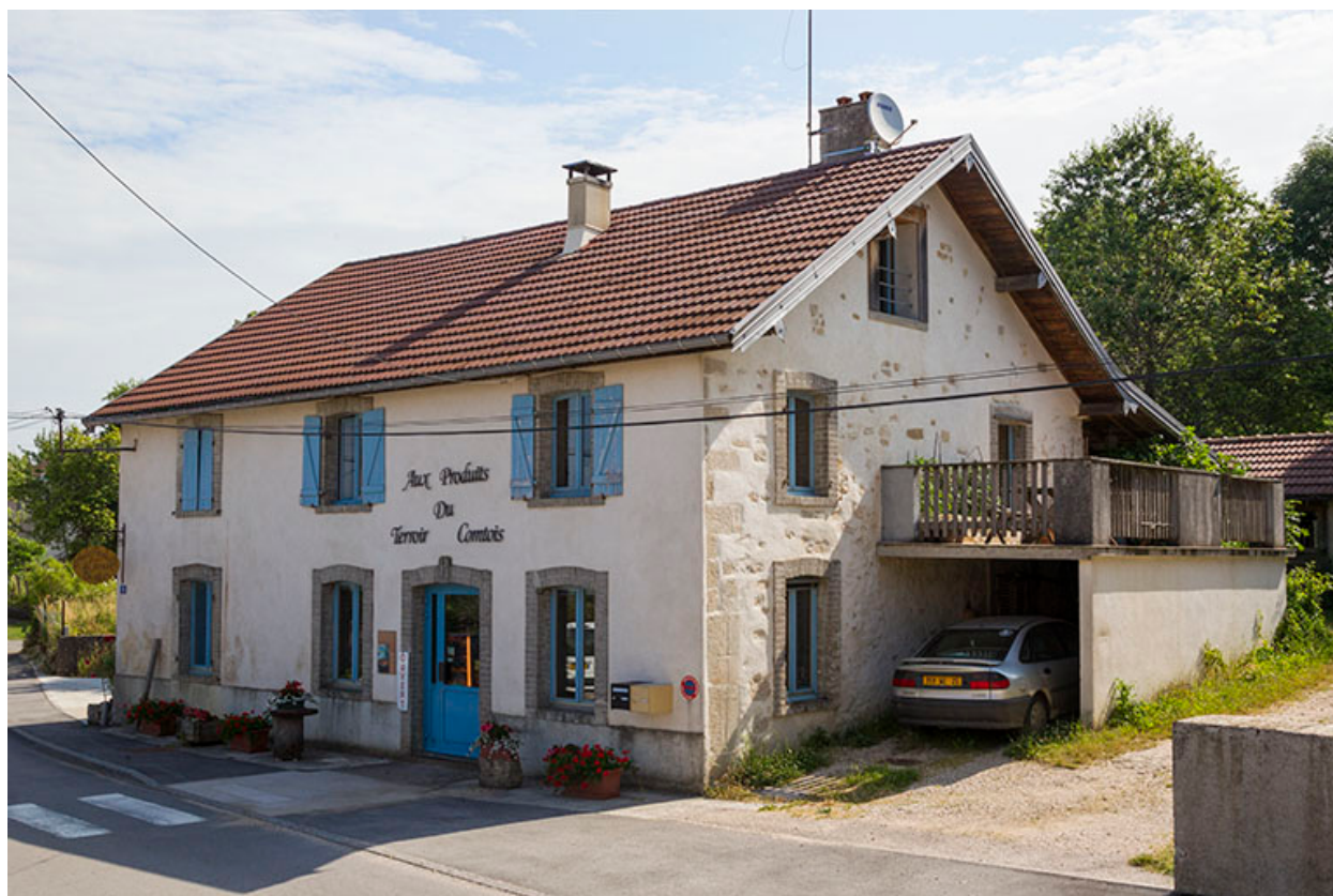
Façades antérieure et latérale droite.
