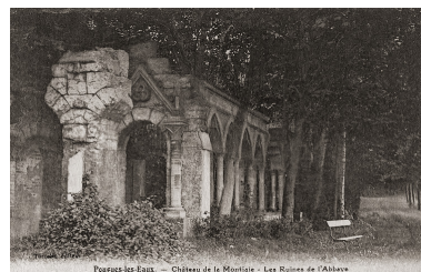
Vue ancienne. Autr. auteur inconnu IVR26_20195800744NUC4A
