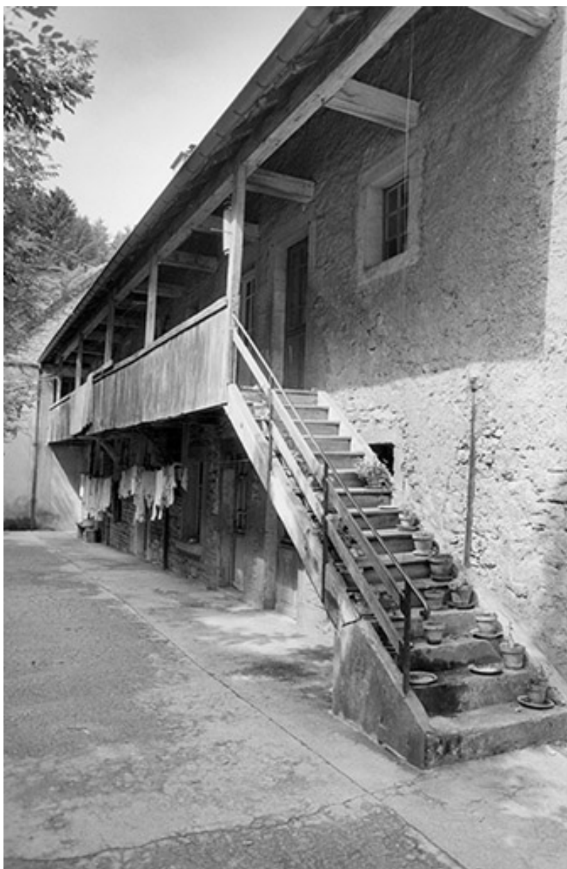
Façade postérieure d'un logement ouvrier en 1980.
