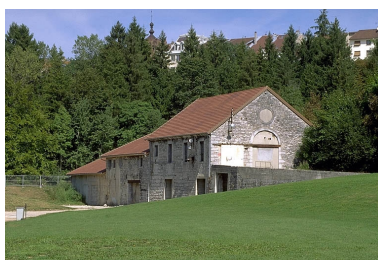
Ateliers de fabrication (galvanisation).
