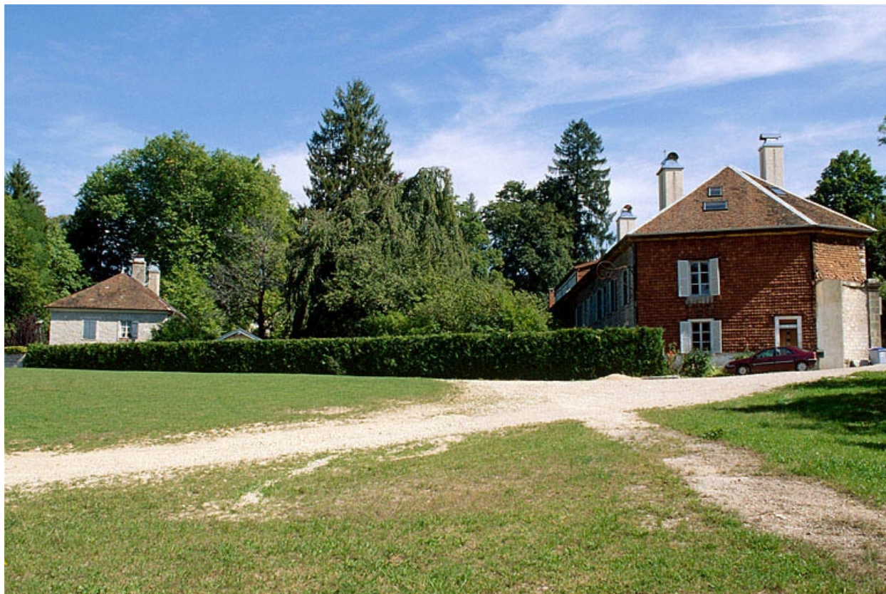
Logement patronal et bureaux.
