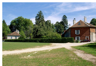
Logement patronal et bureaux.
