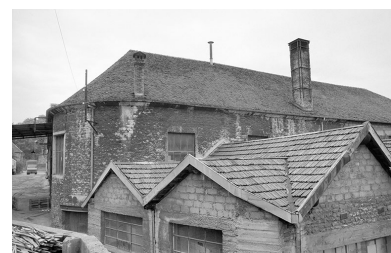
Extrémité est de l'atelier de forge en 1980. Phot. Jack Dumont IVR43_19803900314Z
