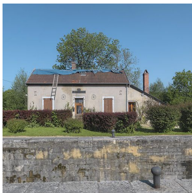
Maison éclusière de face. Phot. Thierry Kuntz IVR26_20122102360NUC4A
