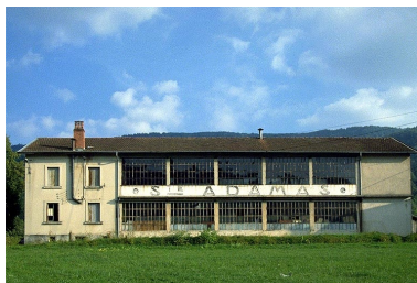
Façade antérieure. Phot. Laurent Poupard IVR43_19903900575ZA
