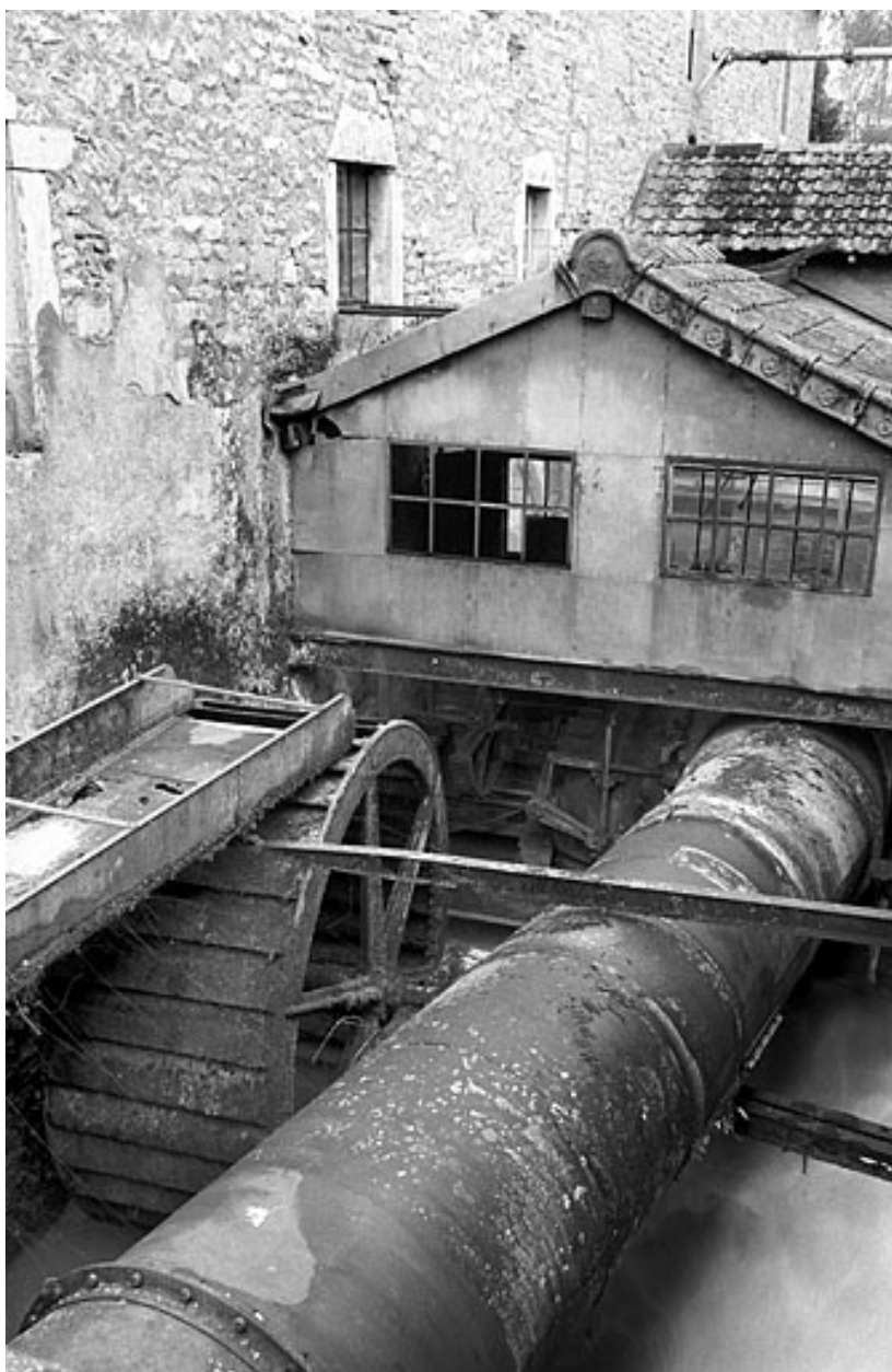
Roue hydraulique, conduite forcée et bâtiment d'eau.
