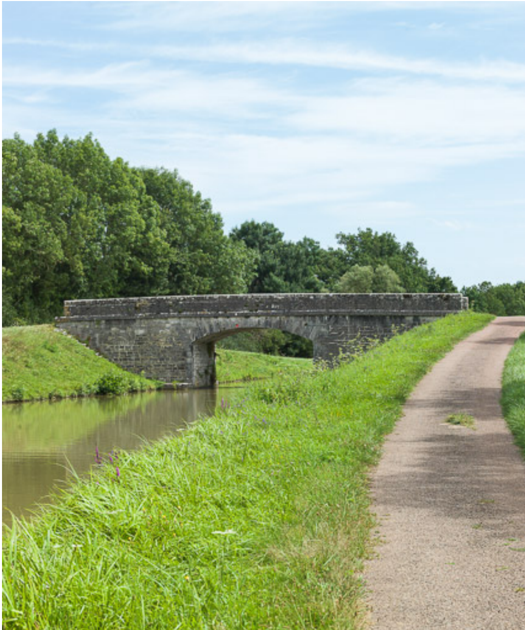
Vue d'ensemble du pont.
