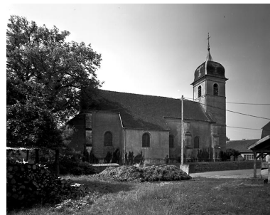
Façade latérale gauche. Phot. Yves Sancey IVR43_19837000126V
