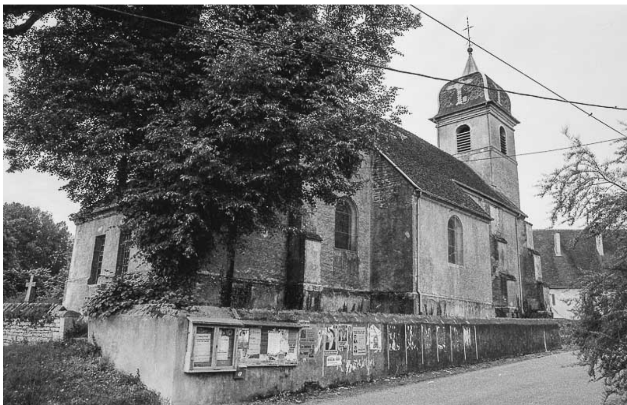
Façades latérale gauche et postérieure.
