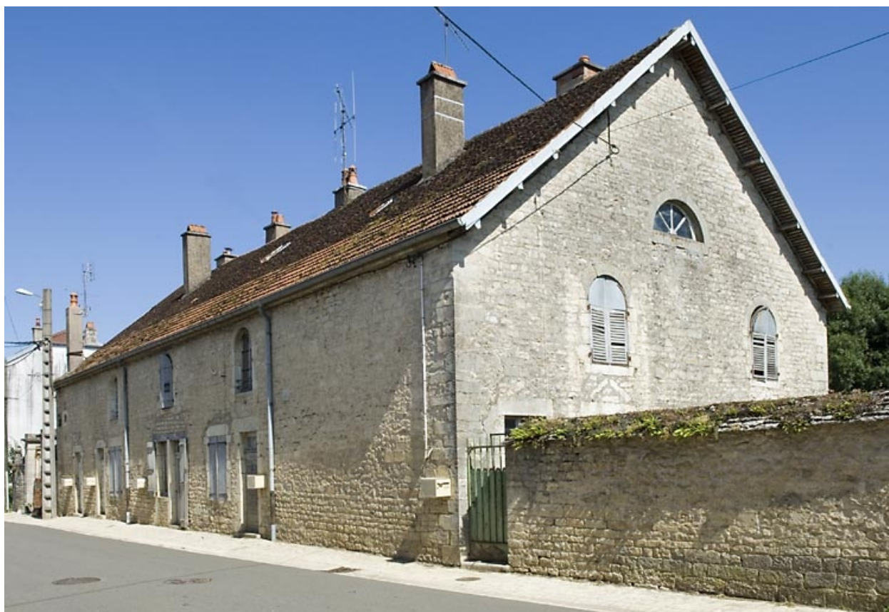
Logement ouvrier depuis l'ouest.
