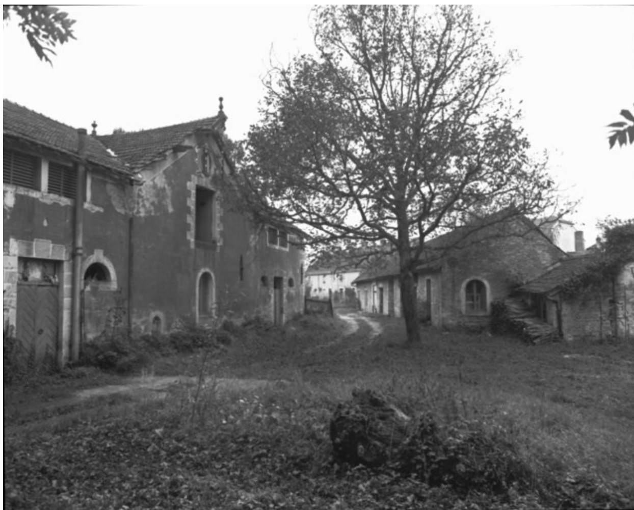
Ecurie et logement ouvrier depuis l'est en 1989.
