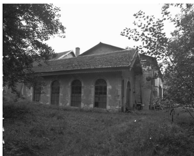
Orangerie (?) en 1989. Phot. Yves Sancey IVR43_19897000626X
