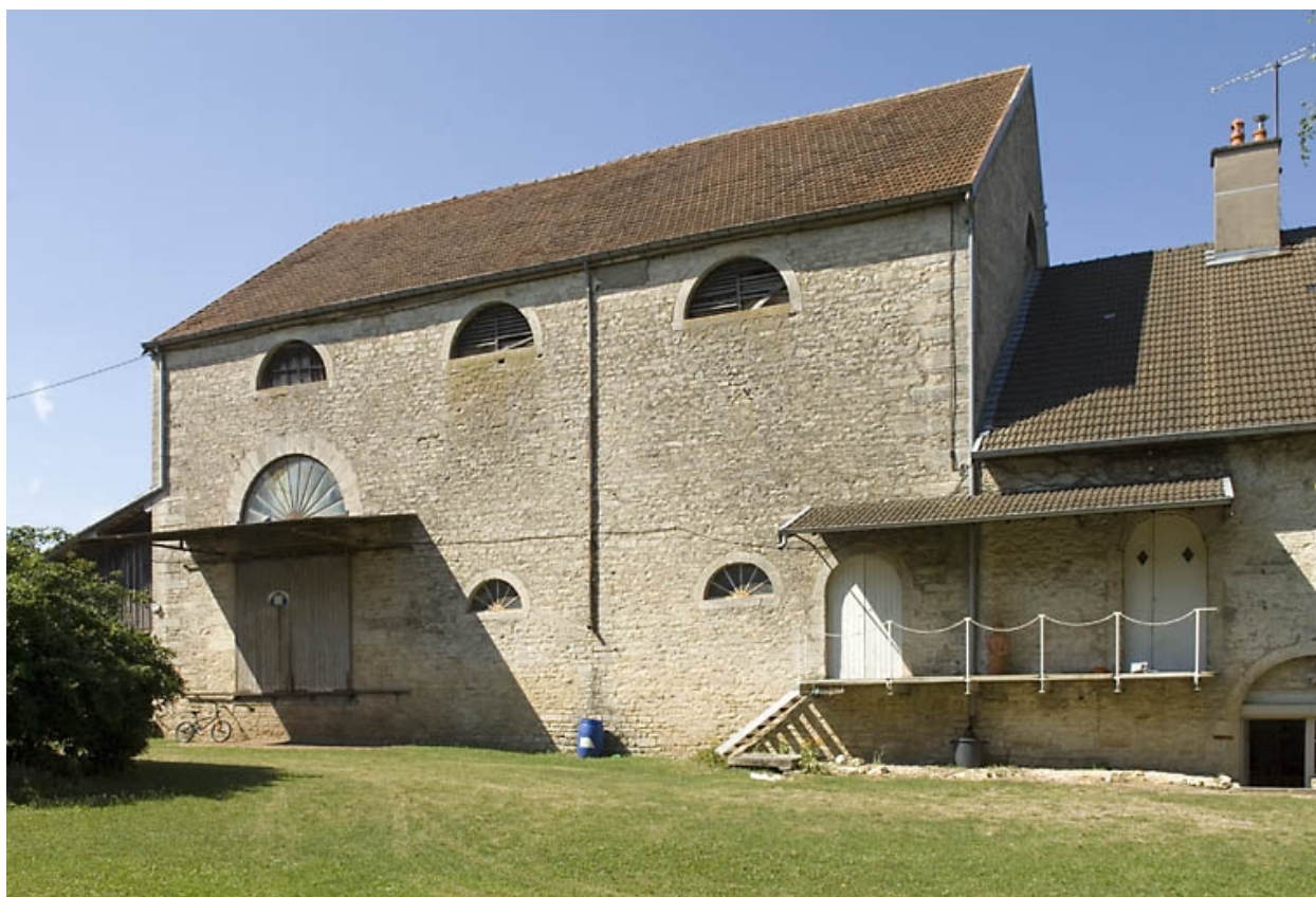
Façade sud du haut fourneau.
