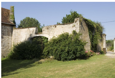
Vestiges de la halle à charbon. Phot. Jérôme Mongreville IVR43_20087000604NUC2A
