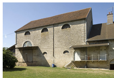
Façade sud du haut fourneau. Phot. Jérôme Mongreville IVR43_20087000611NUC2A
