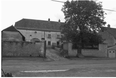
Vue d'ensemble depuis la rue. Phot. Bernard Lardière IVR43_19817000269Z
