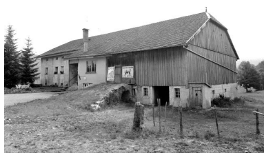
Ferme située au lieu-dit La Motte Phot. Dominique Humbert IVR43_19762500161X
