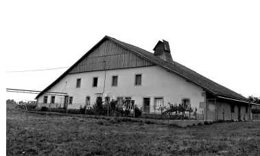
Ferme située au lieu-dit Les Duquets
