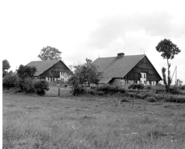
Ferme située au lieu-dit La Motte Phot. Yves Sancey IVR43_19772500352X
