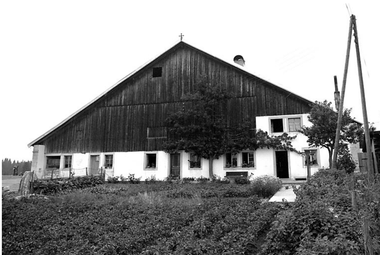
Ferme située au lieu-dit Les Duquets
