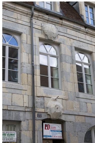
Façade antérieure : détail des pierres d'attente épannelées sur la porte du couloir et d'une fenêtre de l'étage. Phot. Yves Sancey IVR43_20122500661NUC2A
