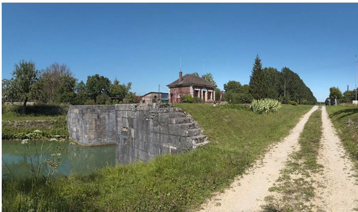
Vue de la tête amont du sas.
