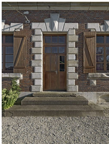
Maison éclusière : porte arrière. Phot. Thierry Kuntz IVR26_20118900178NUC4A
