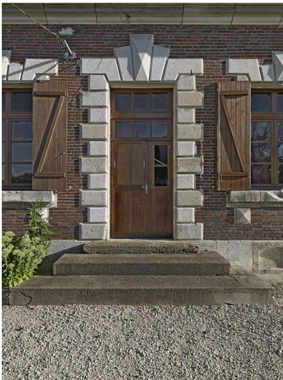
Maison éclusière : porte arrière.
