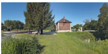
Maison éclusière : côté droit. Phot. Thierry Kuntz IVR26_20118900150NUC4A
