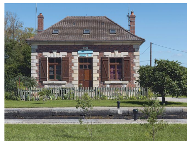
Maison éclusière : vue de face. Phot. Thierry Kuntz IVR26_20118900167NUC4A
