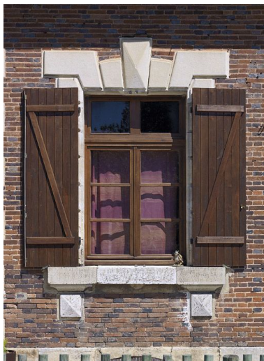
Maison éclusière : détail de la fenêtre.
