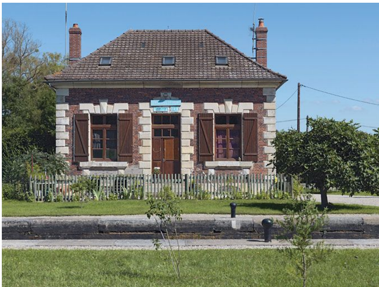
Maison éclusière : vue de face.
