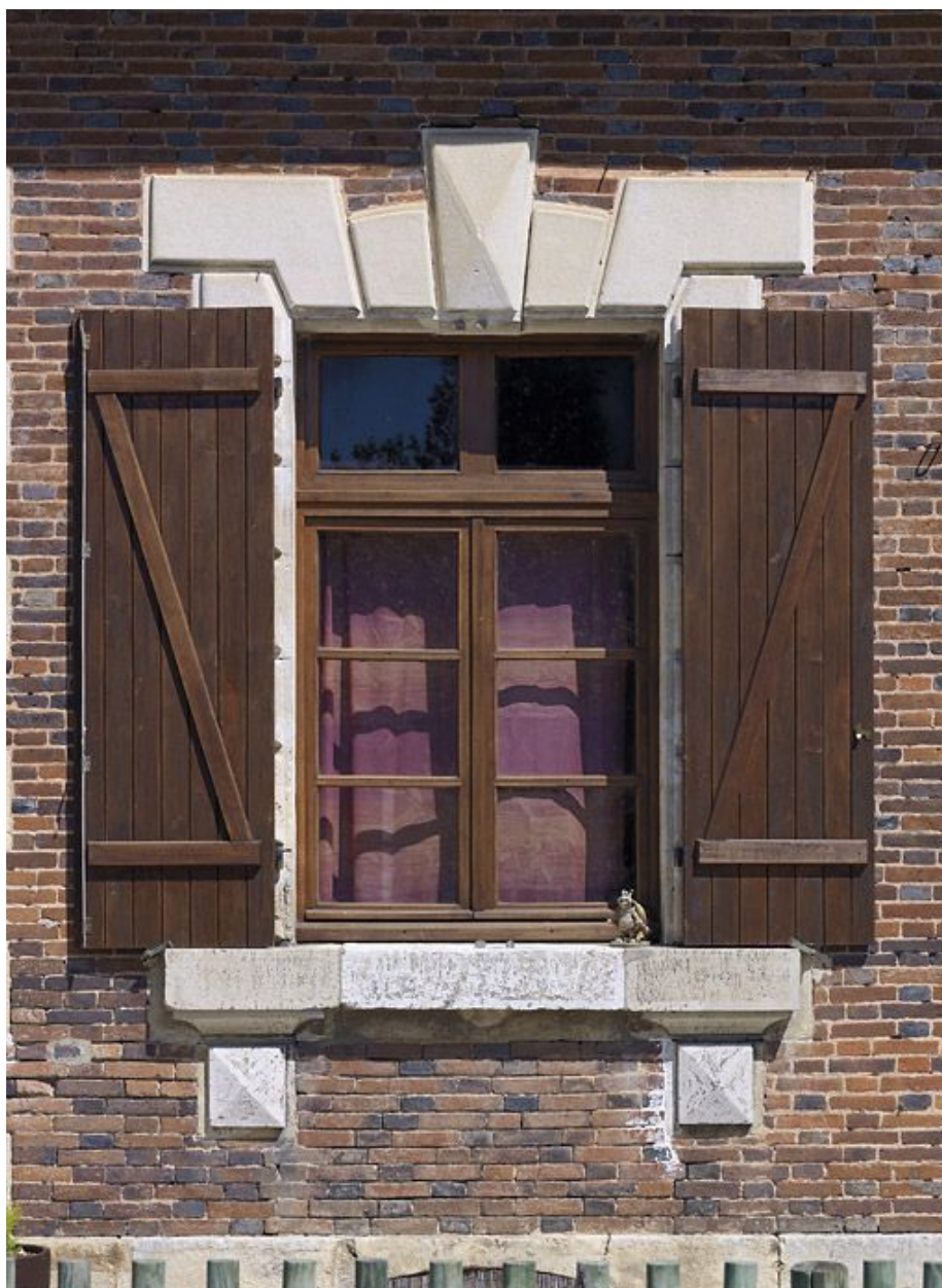
Maison éclusière : détail de la fenêtre.
