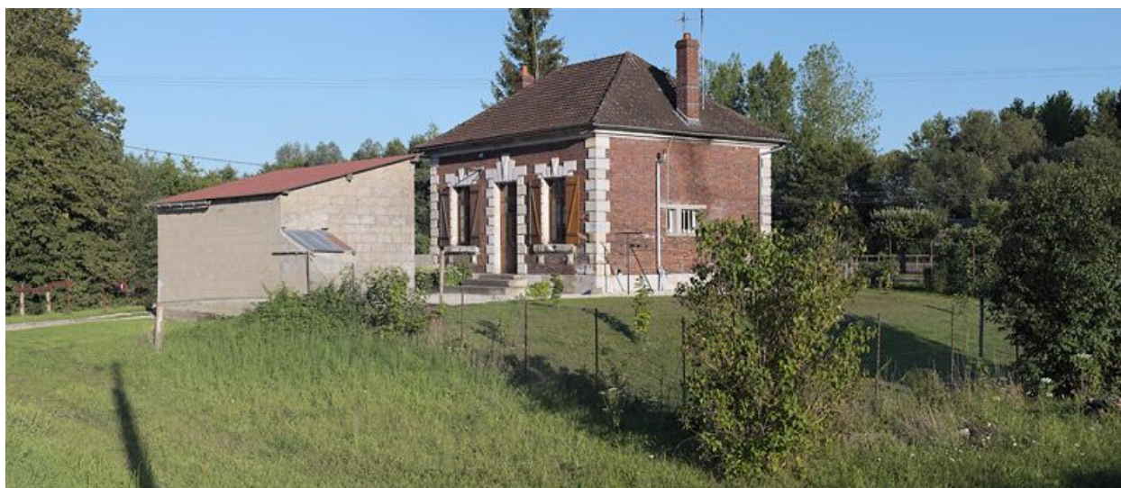
Maison éclusière : 3/4 arrière.
